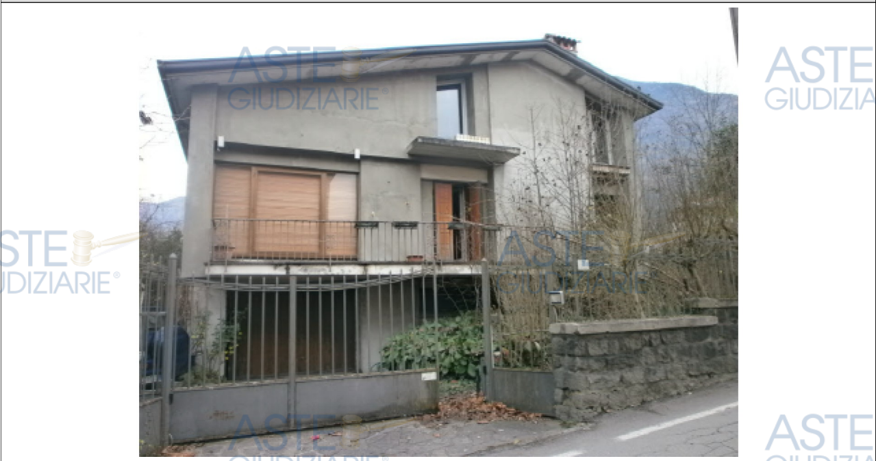
N. 11 - Vista lato ovest, su via Montiglio.
