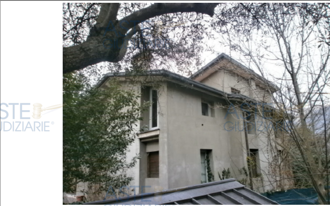
N. 23 - Vista lato sud e scorcio lato ovest
