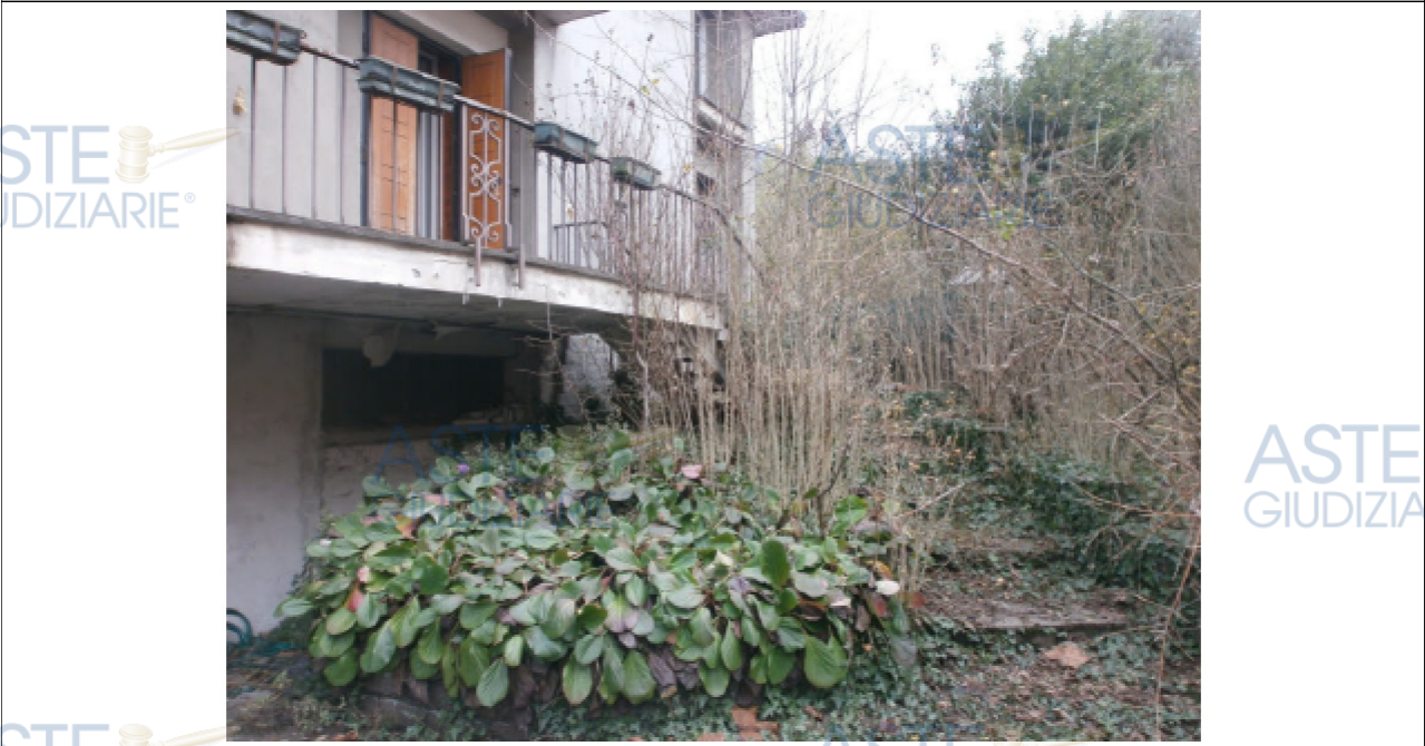
N. 12 - Zona ingresso, lato ovest
