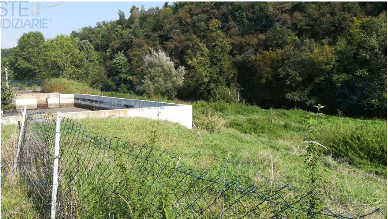
Prossimità delle vasche stoccaggio al fiume Chiese
