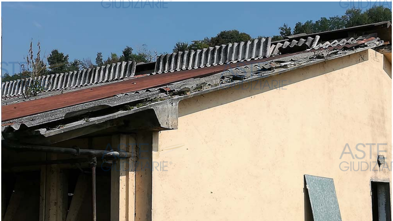
Particolare della copertura precedente
