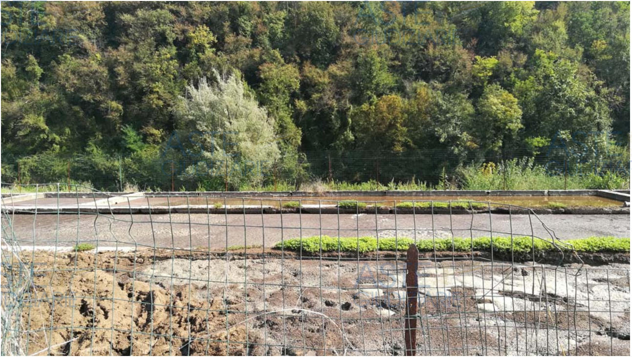
Particolare dei condotti di scolo verso il Chiese
