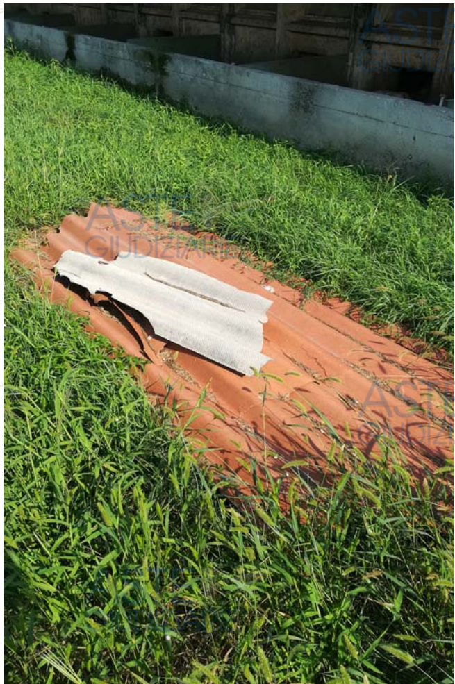
copertura pozzetti fognari con lastra ondulata
