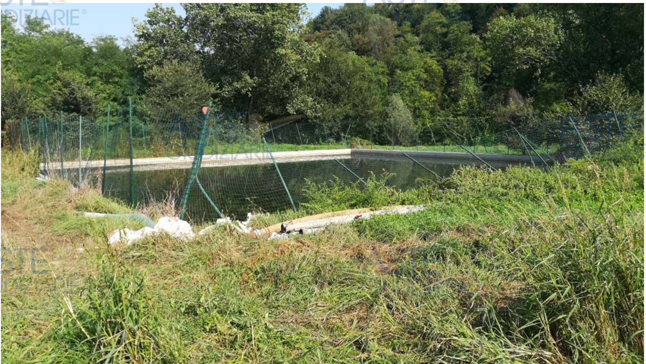
Vasca stoccaggio liquami con rete abbattuta
