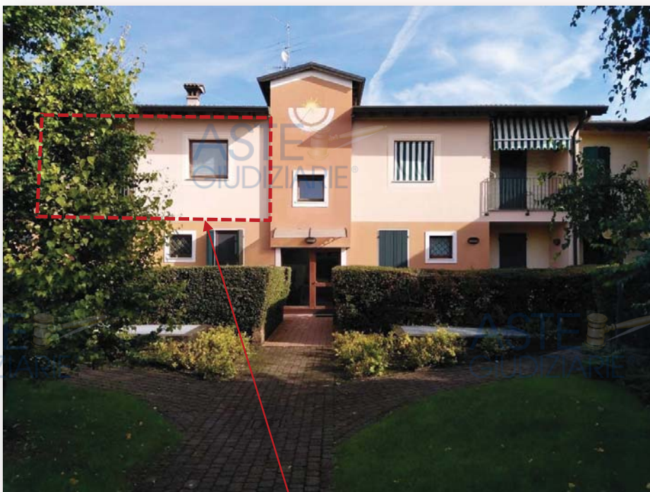
L'ingresso al vano scala che serve il BENE 1 (Piano primo a sinistra) e il BENE 2 (Piano interrato)
