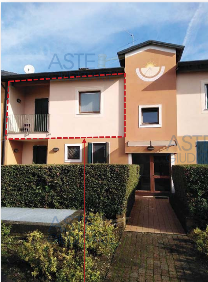
L'ingresso al vano scala che serve il BENE 1 (Piano primo a sinistra) e il BENE 2 (Piano interrato)
