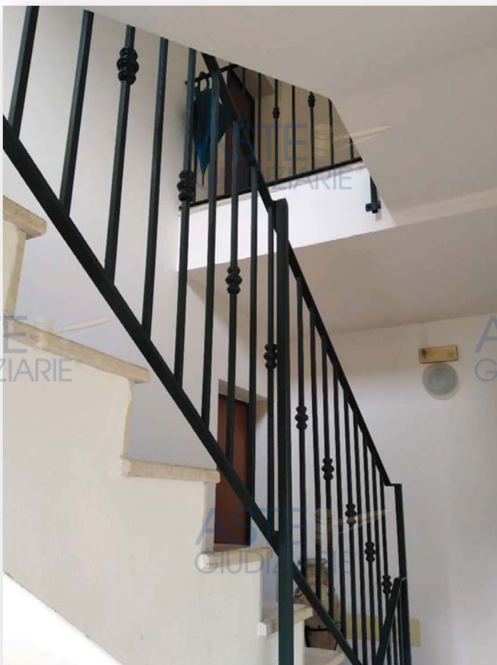
Il vano scala comune al Piano Terra
