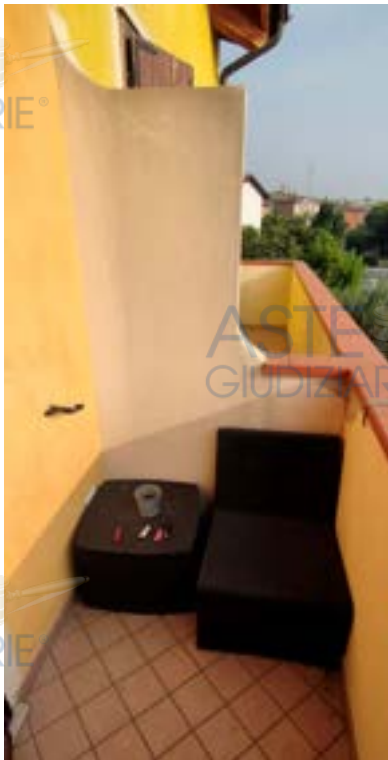
Balcone piano primo
