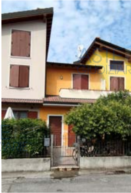
Vista accesso pedonale
