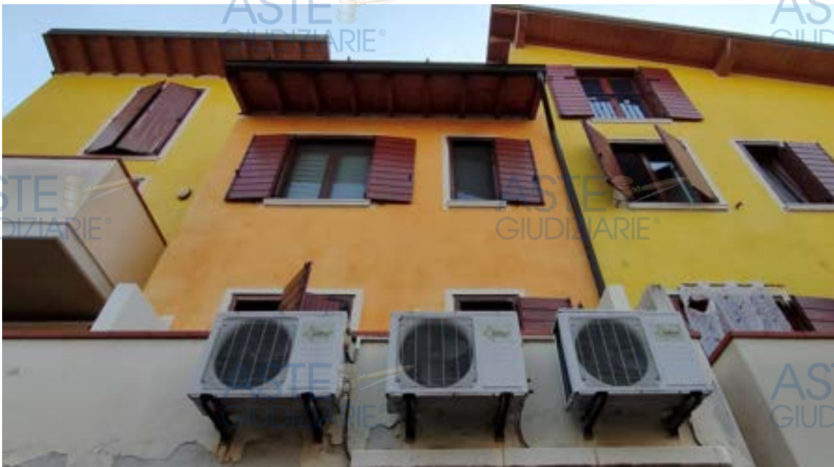
Fronte ovest (vista dal corsello)
