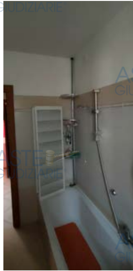
Vista bagno piano primo
