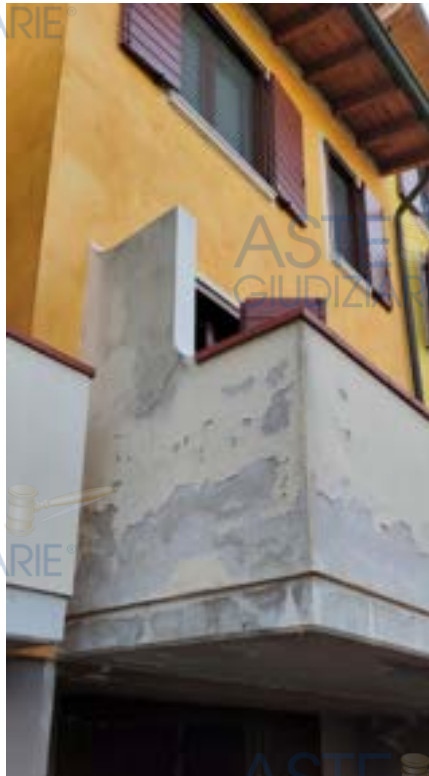
Ammaloramento parapetto
