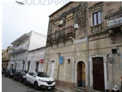
Prospetto su Via Melissa Bassi 31
