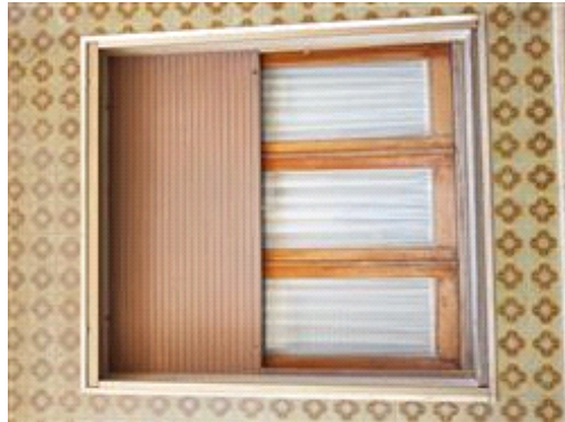
foto interna della finestra prospiciente la via Balilla
