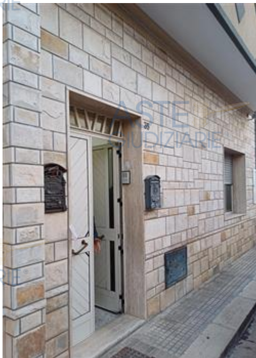
Foto n.1 - vista esterna del prospetto su Via Monte S. Bernardo
