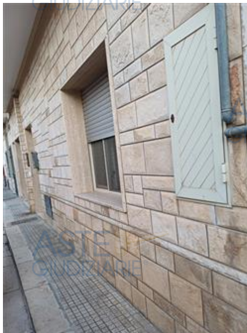
Foto n. 2 - vista esterna del prospetto su Via Monte S. Bernardo
