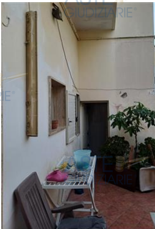
Foto n. 3 - vista esterna del prospetto retrostante prospiciente il cortile interno
