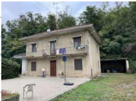
L'intero corpo di fabbrica, ospitante al proprio interno le unità rif. §3.1.2. e §3.1.4, presenta struttura in laterizio e tetto a falde con copertura in tegole portoghesi, cornicione in
