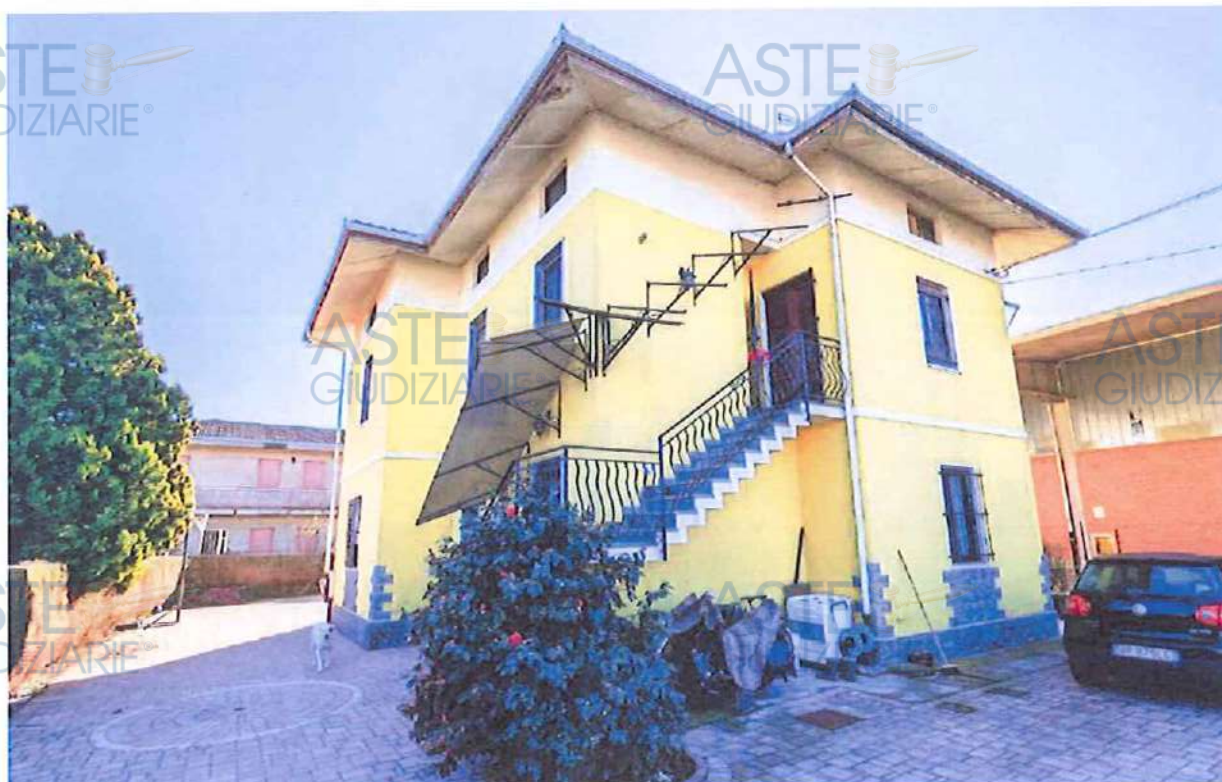
Fabbricato principale – prospetto nord
