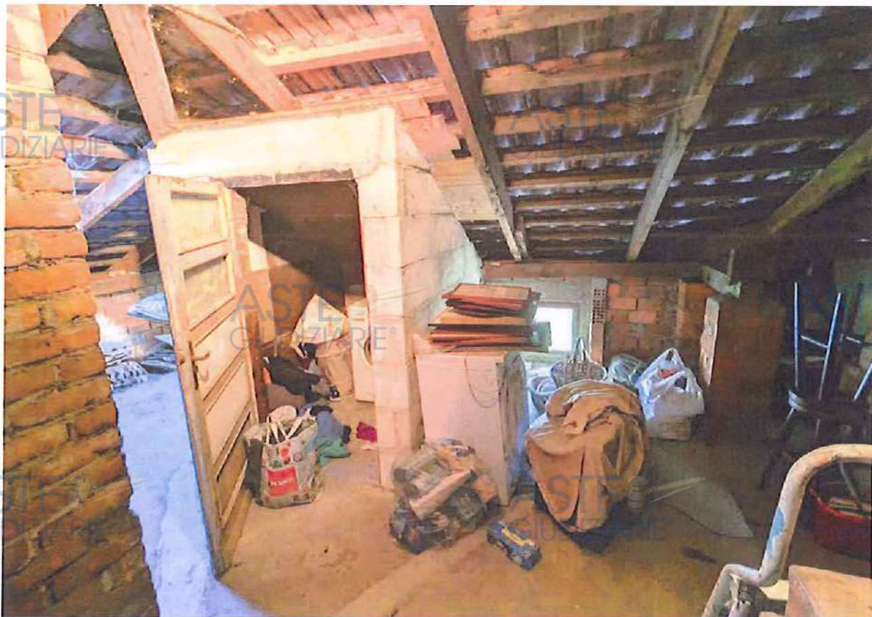
Fabbricato principale P2- sottotetto a nudo tetto
