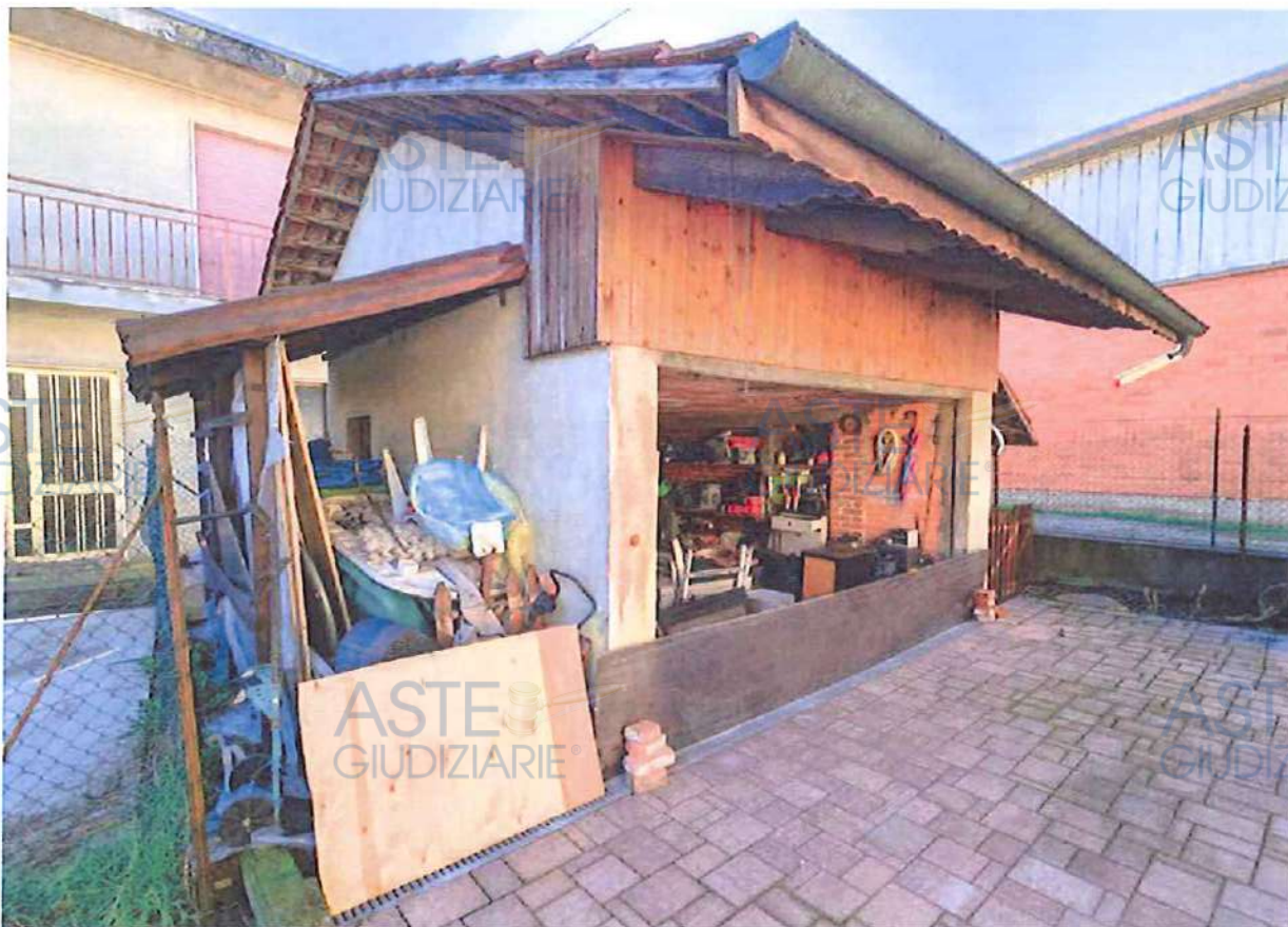
Fabbricato secondario – autorimessa
