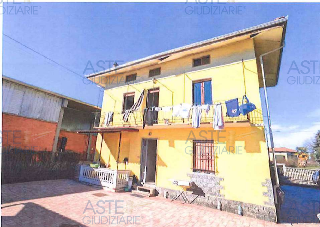
Fabbricato principale – prospetto sud
