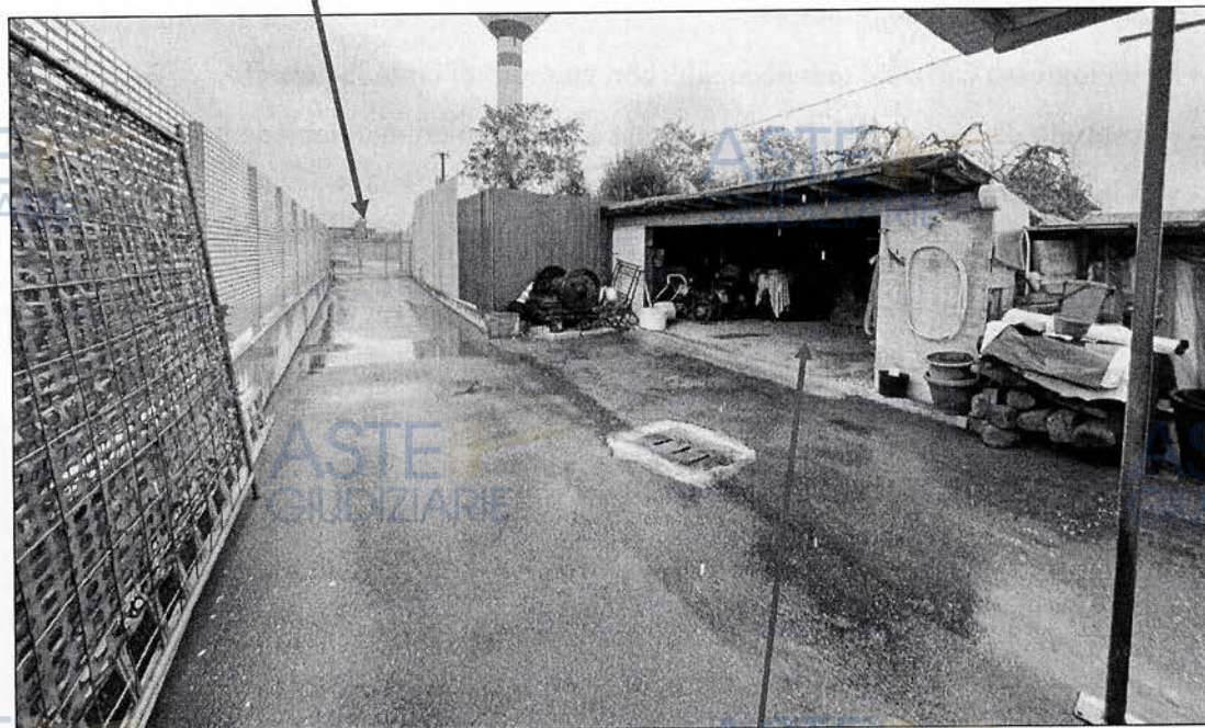
Tettoia adibita a magazzino
