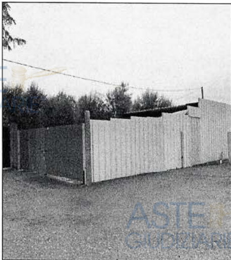
Recinzione con ingresso carrabile
