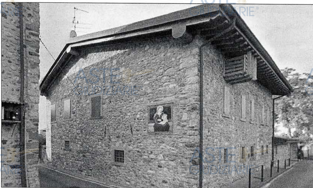
Facciate esterne prospettate su via Badie
