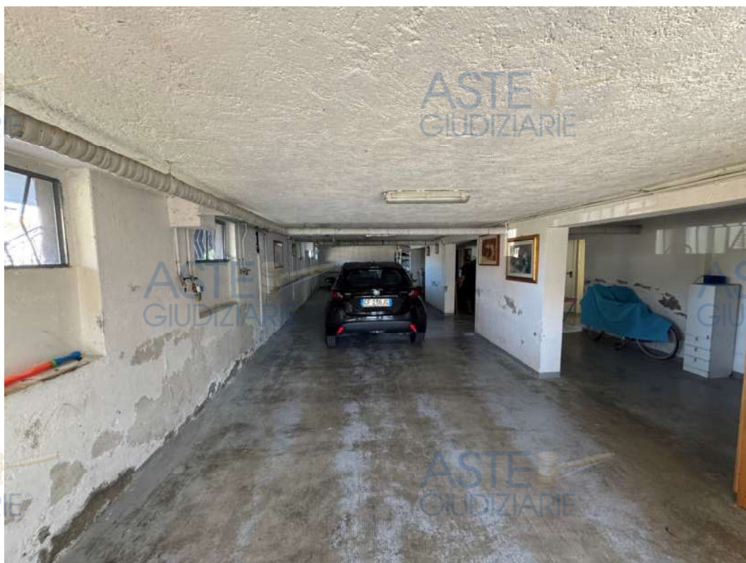
Foto 08 – Piano seminterrato area comune
