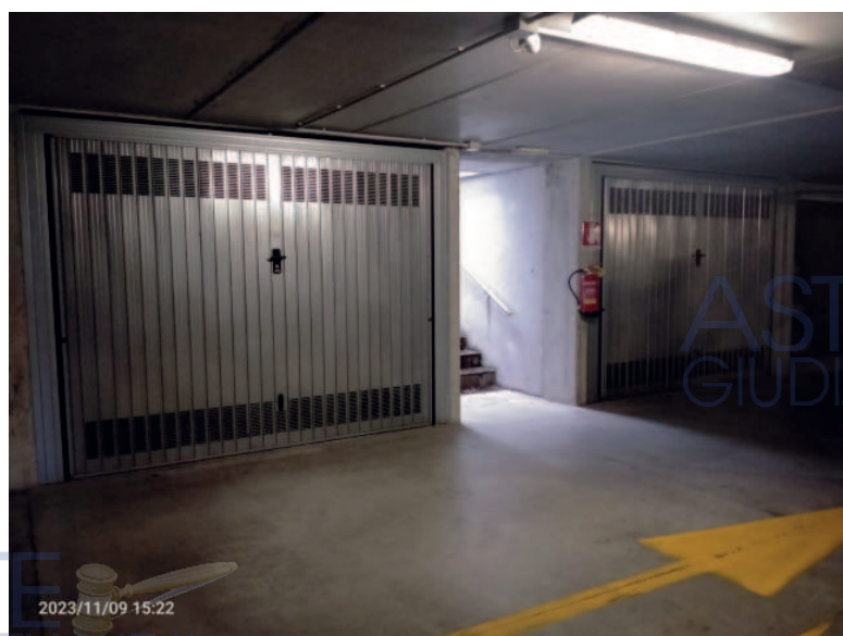
box sub 754 a valle della scala
