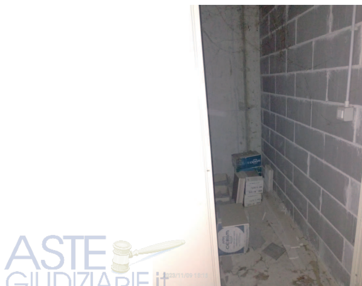
cantina sub 36 vista interno
