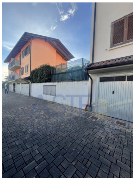
posti auto esterni al fabbricato
