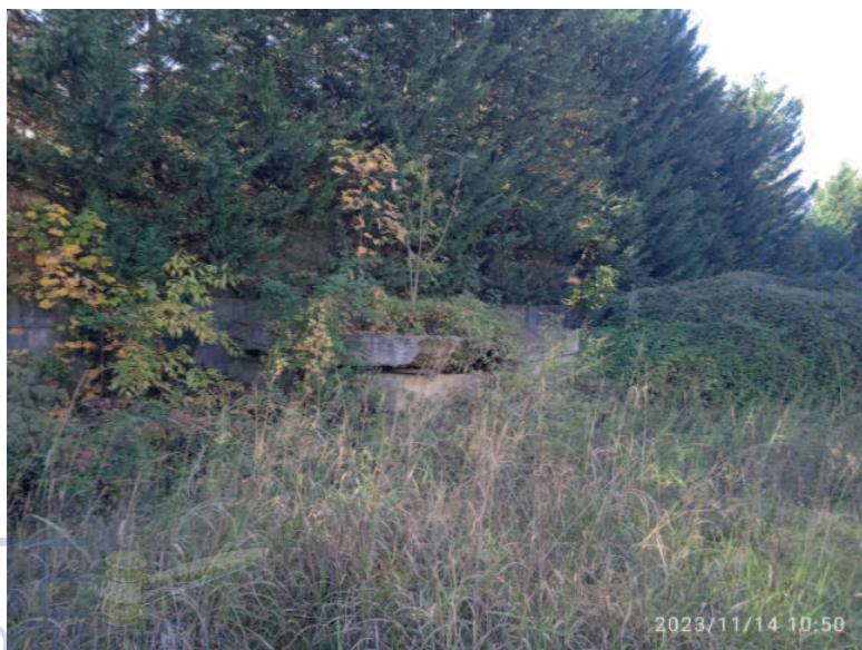
zavorre gru depositate
