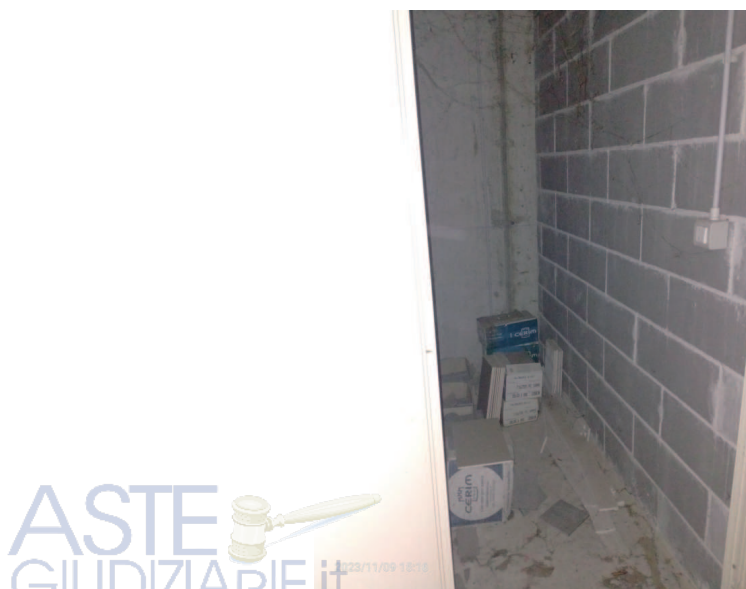
cantina sub 36 vista interno
