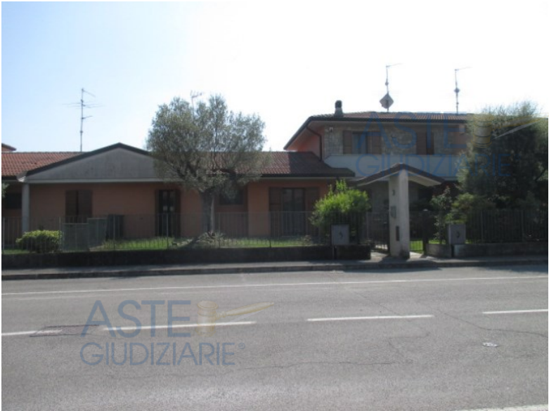
vista fronte strada
