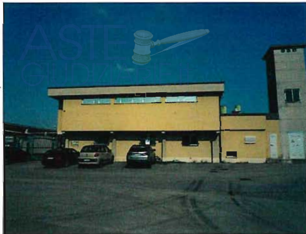
FOTO 40 – CORPO 13 FRONTE OVEST
