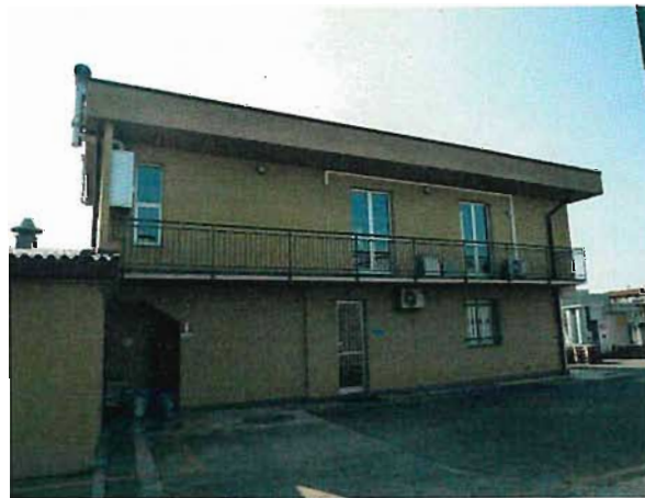
FOTO 41 – CORPO 13 FRONTE EST
