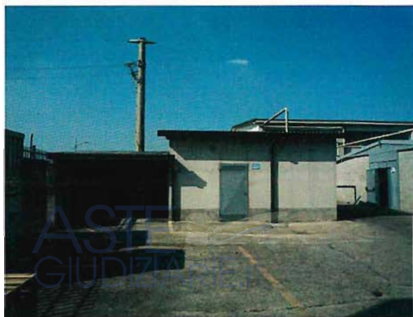
FOTO 44 – CORPO 14 FRONTE SUD
