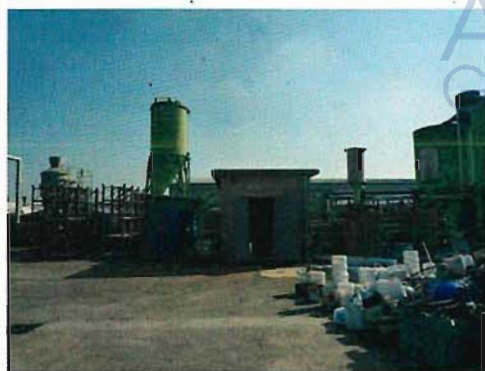
FOTO 33 – CORPO 10 FRONTE NORD
