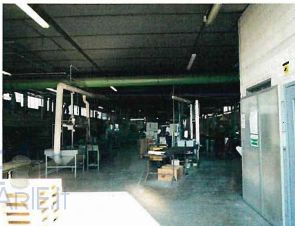
FOTO 8 – INTERNO CAPANNONE CORPO 3
