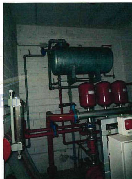
FOTO 47 – INTERNO LOCALE AUTOCLAVE CORPO 14
