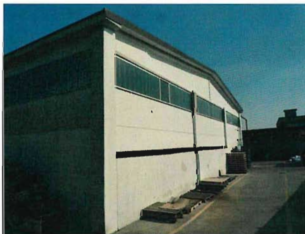
FOTO 1 -CORPO 1 FRONTE OVEST
