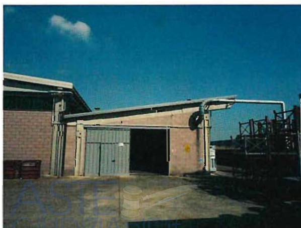
FOTO 31 – CORPO 9 FRONTE OVEST
