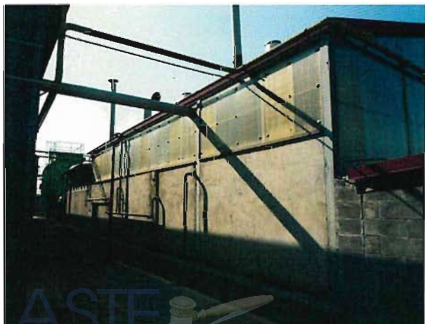
FOTO 11 – CORPO 4 FRONTE SUD
