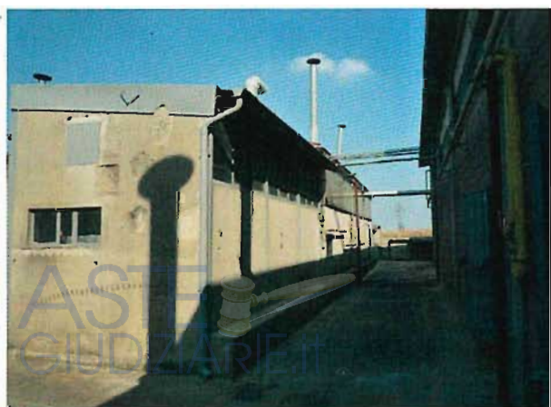
FOTO 19 – CORPO 6 FRONTE SUD
