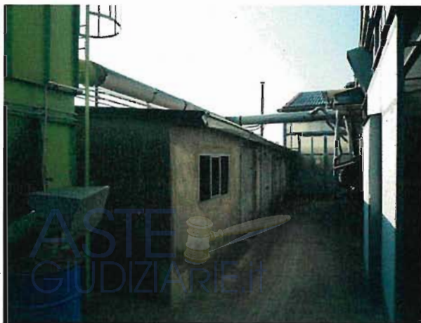
FOTO 21 – CORPO 7 FRONTE OVEST
