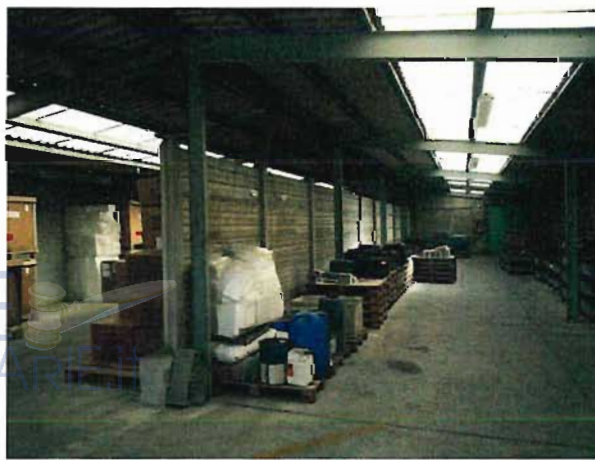
FOTO 4 - INTERNO CAPANNONE CORPO 2
