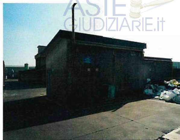
FOTO 45 – CORPO 14 FRONTE NORD
