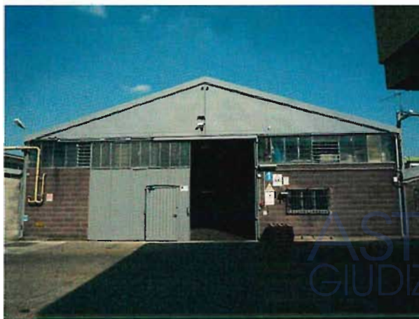
FOTO 7 – CORPO 3 FRONTE OVEST
