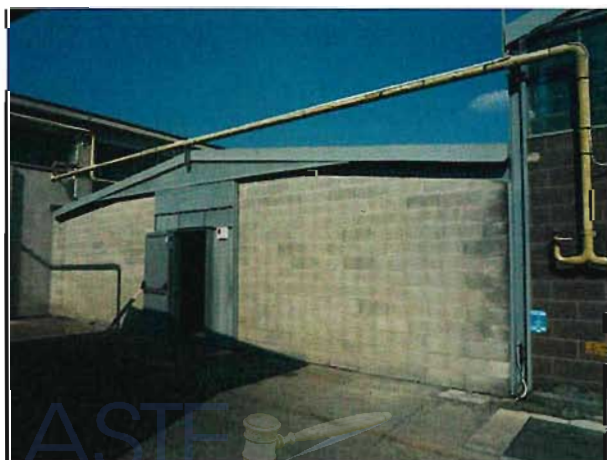
FOTO 5 – CORPO 2 FRONTE OVEST
