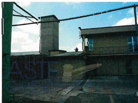
FOTO 38 – CORPO 12 FRONTE EST
