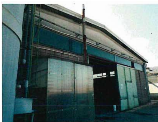
FOTO 26 – CORPO 8 FRONTE EST
