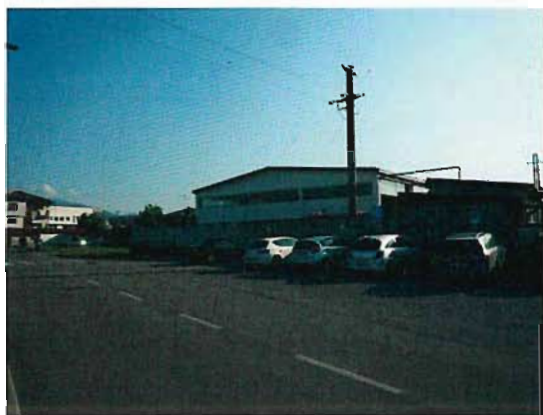
PALO IN CEMENTO FOTO A
