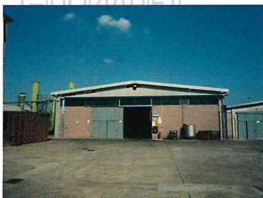
FOTO 25 – CORPO 8 FRONTE OVEST
