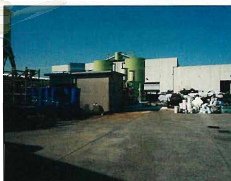
FOTO 34 – CORPO 10 FRONTE EST
