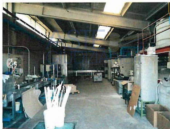
FOTO 32 - INTERNO CAPANNONE CORPO 9
