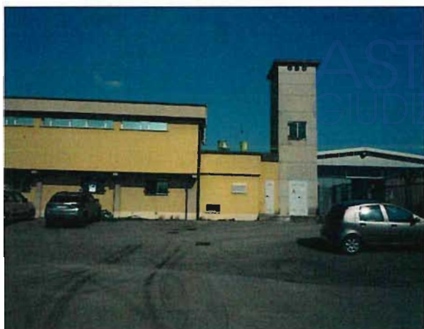
FOTO 36 – CORPO 11 FRONTE OVEST
