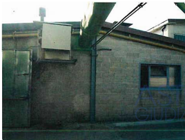
FOTO 3 – CORPO 2 FRONTE EST
