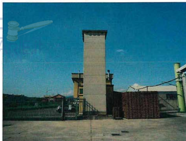
FOTO 37 – CORPO 11 FRONTE SUD
