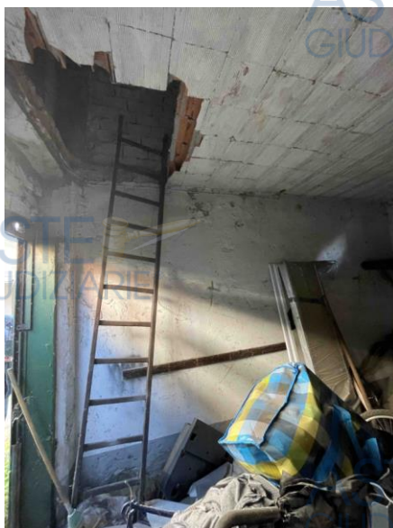
Scala di accesso al deposito
