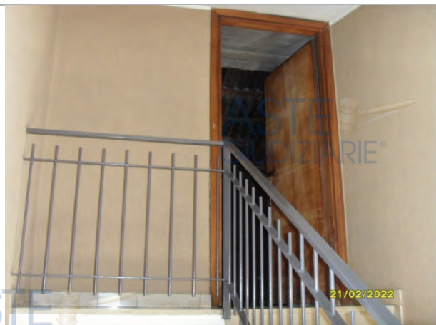
Accesso alla porzione di sottotetto
