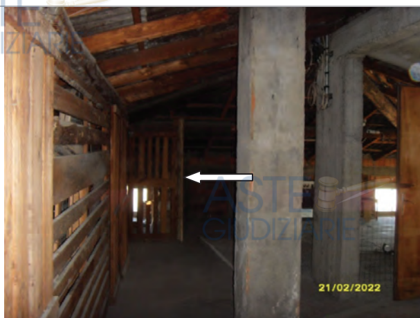
Porzione di sottotetto p.lla 1204 sub 712
