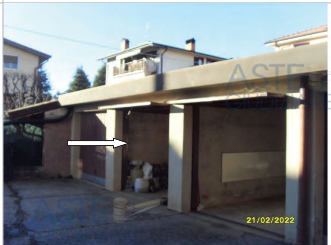
Autorimessa singola p.lla 1242 sub 3
