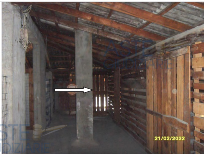
Porzione di sottotetto p.lla 1204 sub 709
