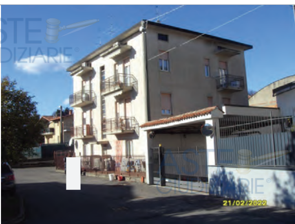
Fabbricato condominiale – Prospetto Sud Est
