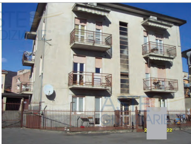
Prospetto Sud fabbricato condominiale
