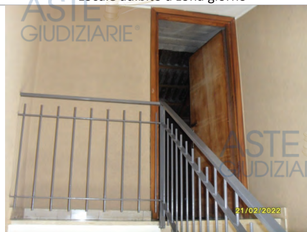
Accesso alla porzione di sottotetto
