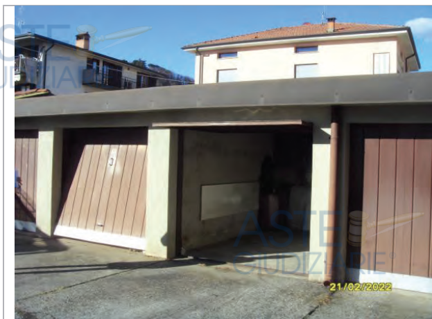
Autorimessa singola p.lla 1242 sub 4
