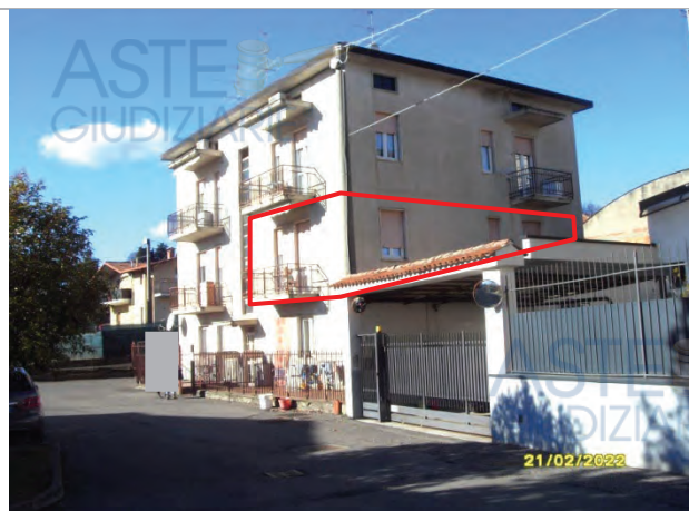
Prospecto Sud Est fabbricato condominiale
