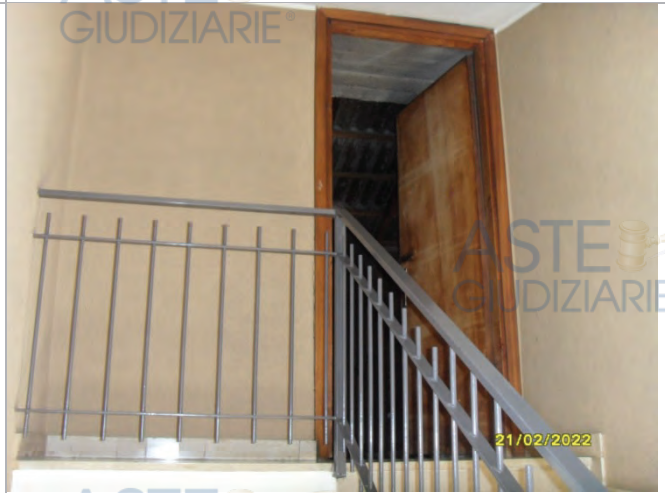
Accesso alla porzione di sottotetto
