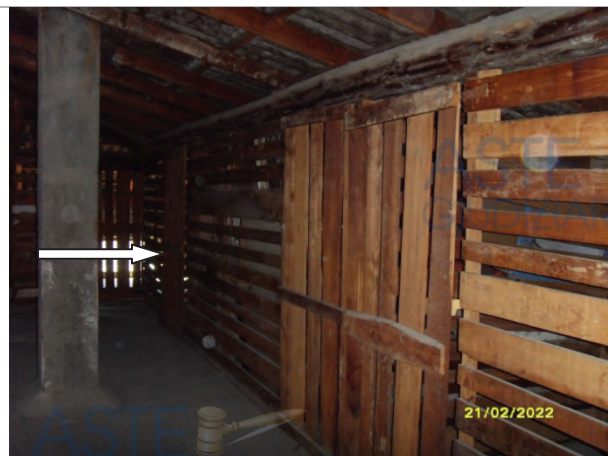
Porzione di sottotetto p.la 1204 sub 710
