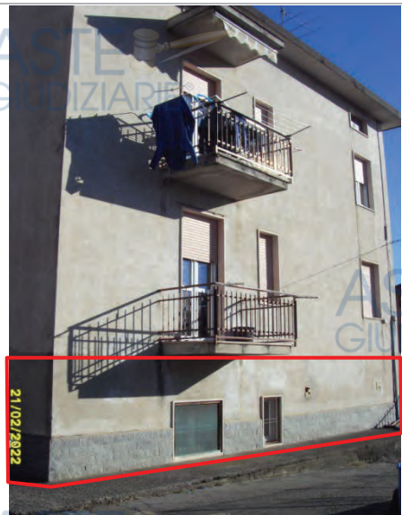
Prospecto Ovest fabbricato condominiale
