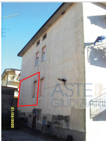
Fabbricato condominiale – Prospecto Nord
