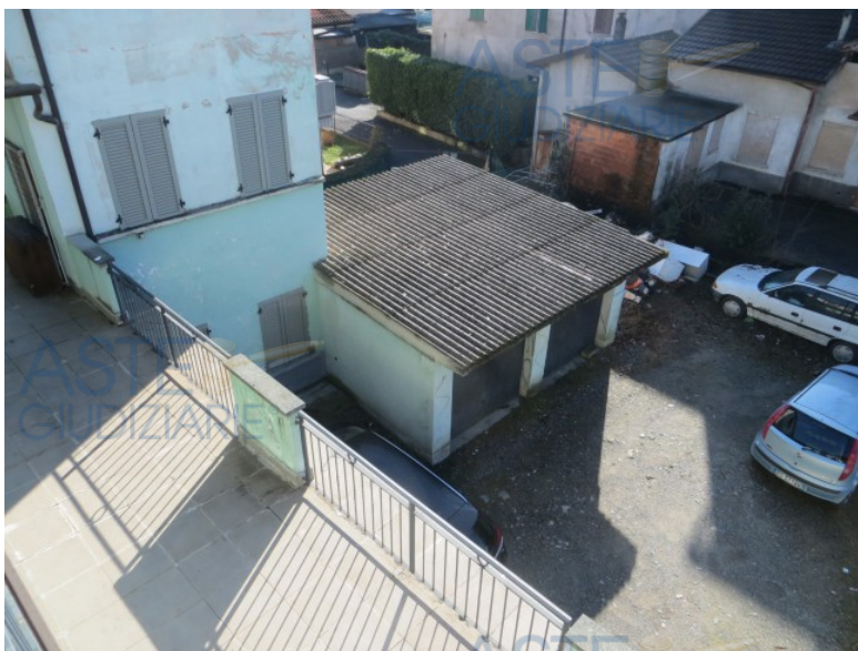
blocco servizi e autorimessa
