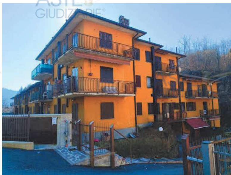
Prospetto e ingresso
