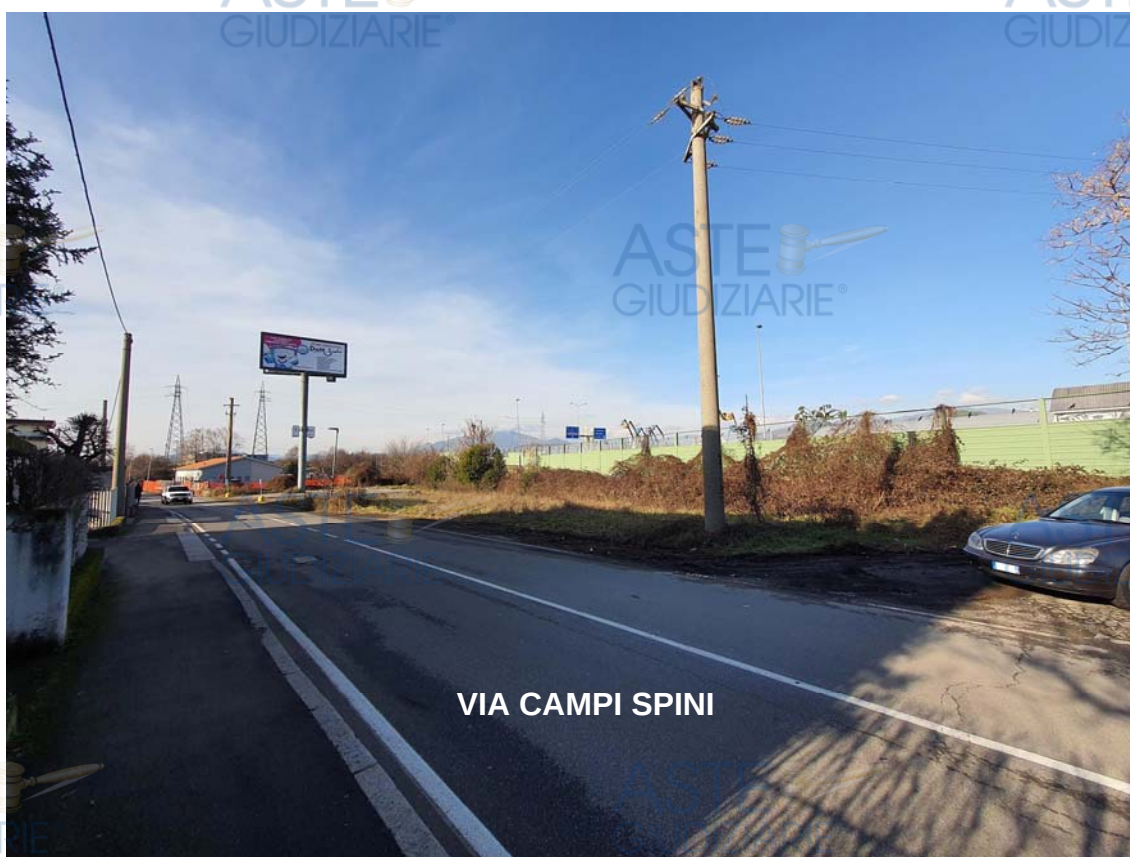
RILIEVO PARTICELLA 3506 – Foto 8 e 9.
