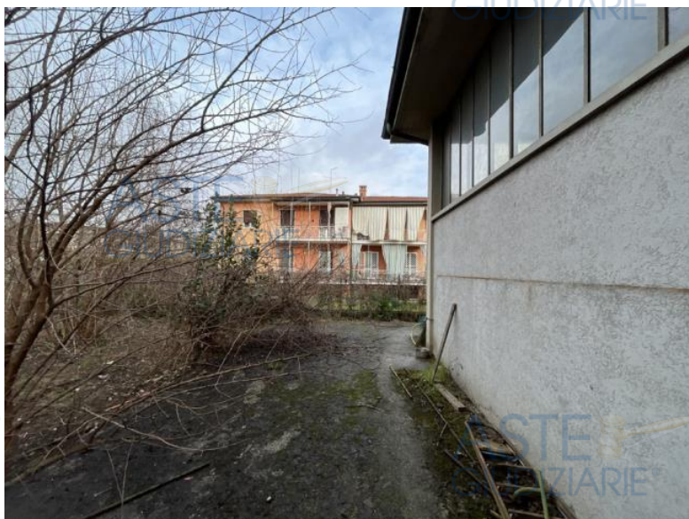
Giardino a nord
