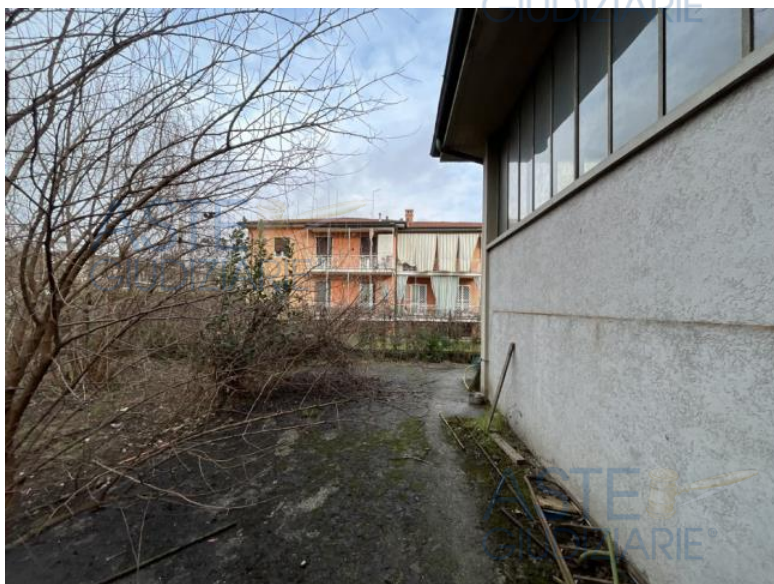
Giardino a nord
