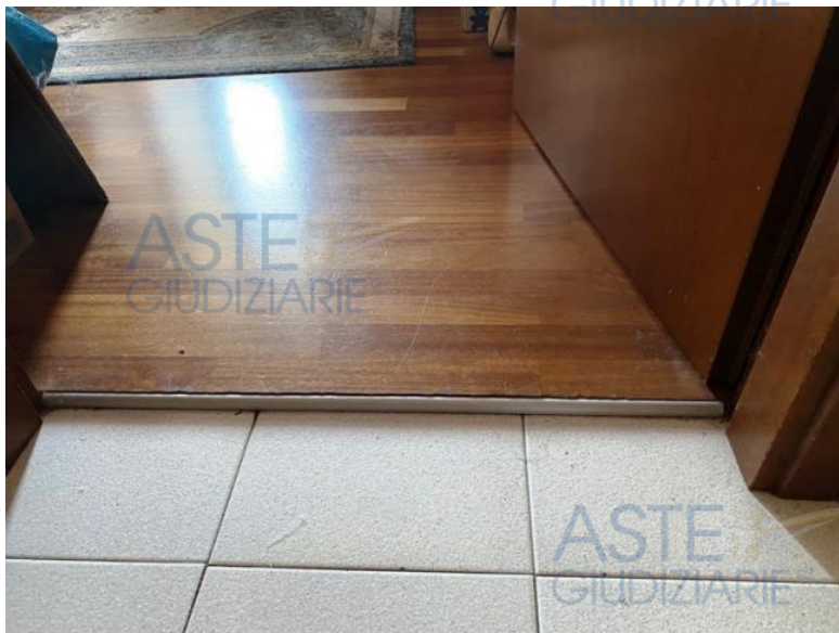
Parquet alla soglia della camera
