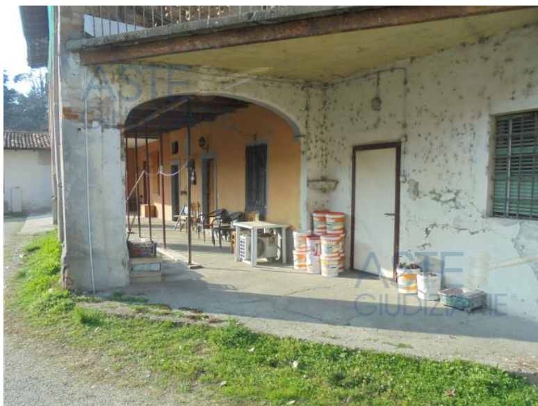
vista porticato da est
