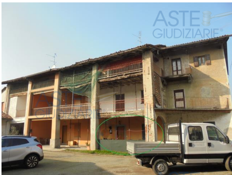
Fronte sud vista generale
