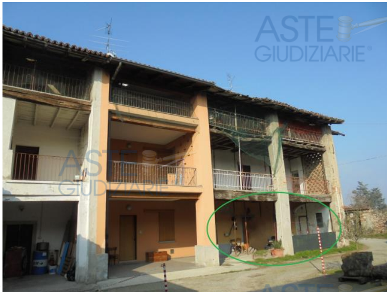
Fronte sud edificio
