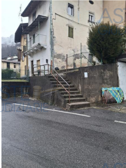
SCALA DI ACCESSO AL GIARDINO
