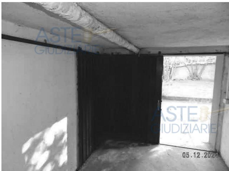
Figure 8 - QUI VEDIAMO IL SERRAMENTO METALLICO SCORREVOLE DA MANUTENZIONARE
