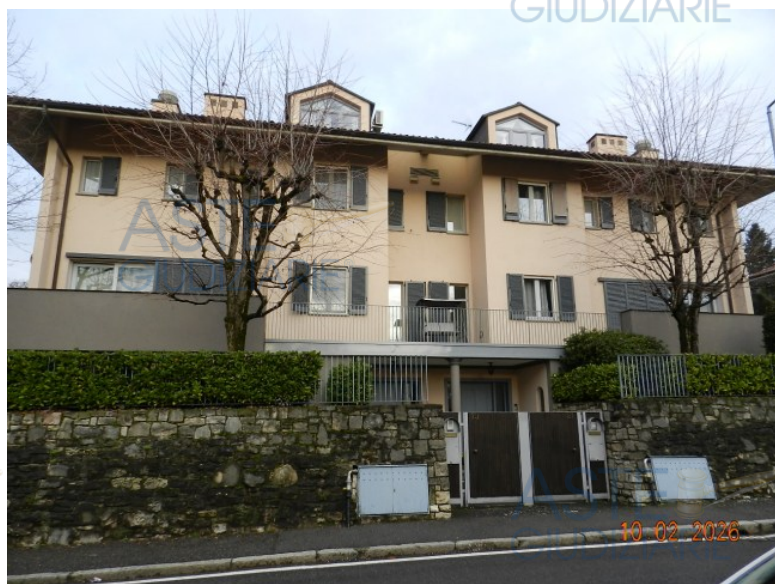
Fotografia 1 – Una vista da via Tomaso Edison
