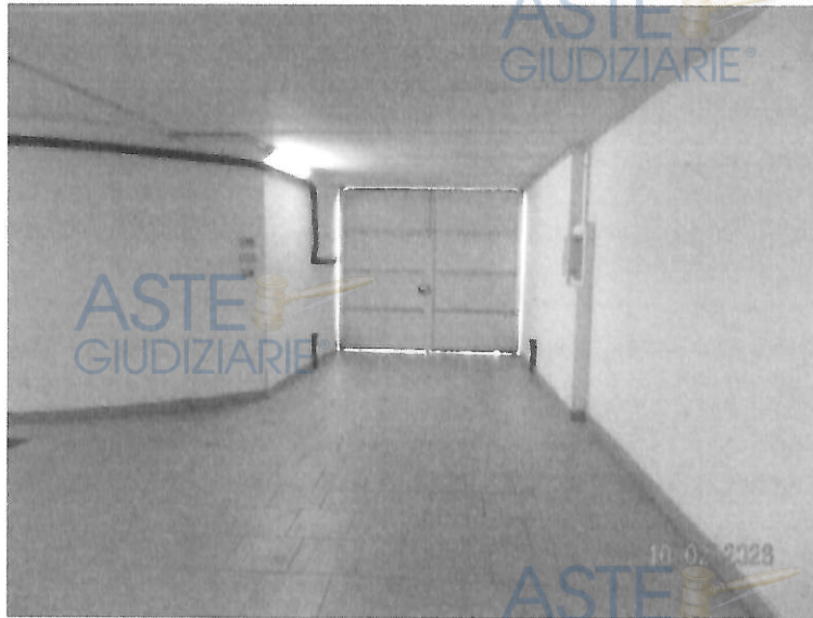
Fotografia 7 - UNA VISTA INTERNA DEL PORTONE D'ACCESSO
