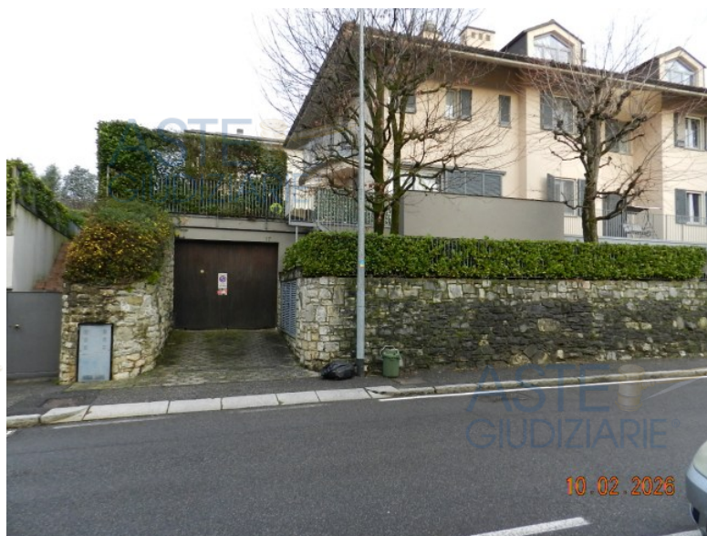
Fotografia 6 - L'INGRESSO SU VIA EDISON
