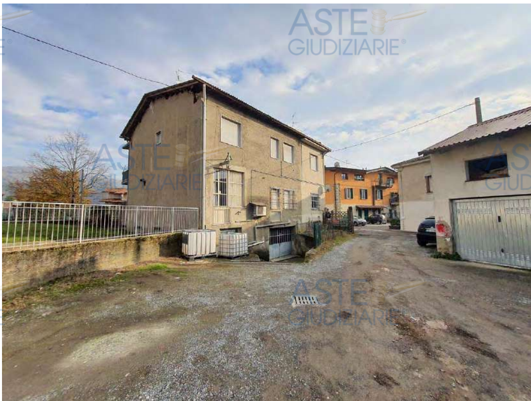
RILIEVO ESTERNO FABBRICATO – Foto 5.
