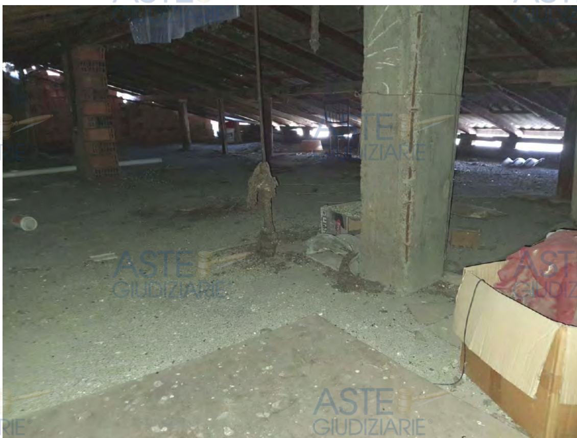
RILIEVO INTERNO PIANO SOTTOTETTO – Foto 59 e 60. Riprese del vano unico a questo livello (Sub. 717) . Si noti il manto di copertura supposto in Eternit.
