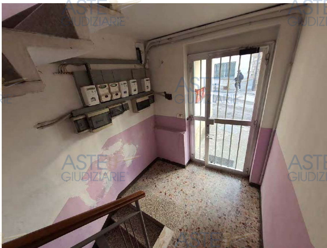
RILIEVO INTERNO ABITAZIONE - 1° P. – Foto 11-13. Riprese del portoncino di ingresso e panoramica del Vano Scale comuni. Si notino i contatori elettrici posizionati nell'androne a P.T..
