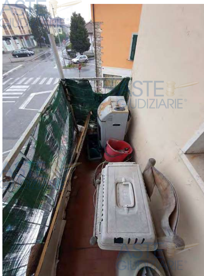
RILIEVO INTERNO ABITAZIONE - 1° P. – Foto 32-34. Riprese della balconata presente sul fronte Est del fabbricato.
