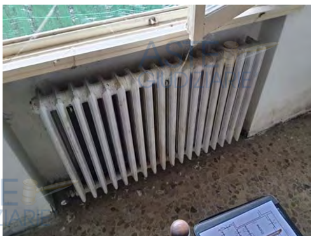
RILIEVO INTERNO ABITAZIONE - DETTAGLI - 1° P. – Foto 41-46. Particolari della caldaia a Metano interna e dei termosifoni in ghisa
