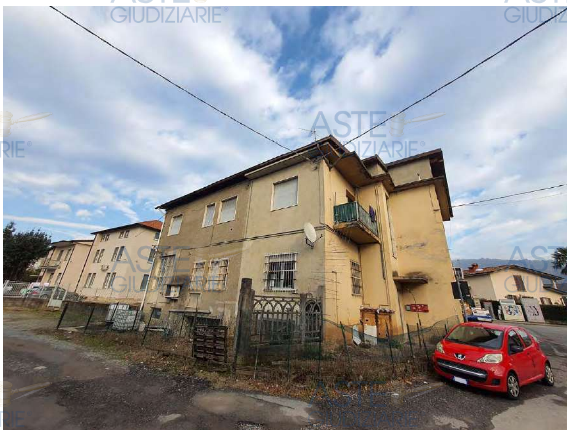
RILIEVO ESTERNO FABBRICATO – Foto 3 e 4. Il fabbricato dell'unità immobiliare oggetto di esecuzione: fronti Sud ed Ovest.
