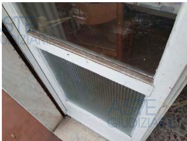
RILIEVO INTERNO ABITAZIONE - DETTAGLI - 1° P. – Foto 47-51. Particolari di porte finestrate e finestre in legno senza vetro-camere e avvolgibili in PVC.
