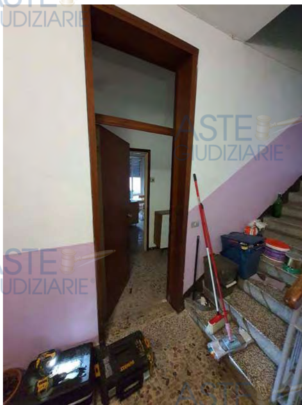
RILIEVO INTERNO ABITAZIONE - 1° P. – Foto 21-23.
