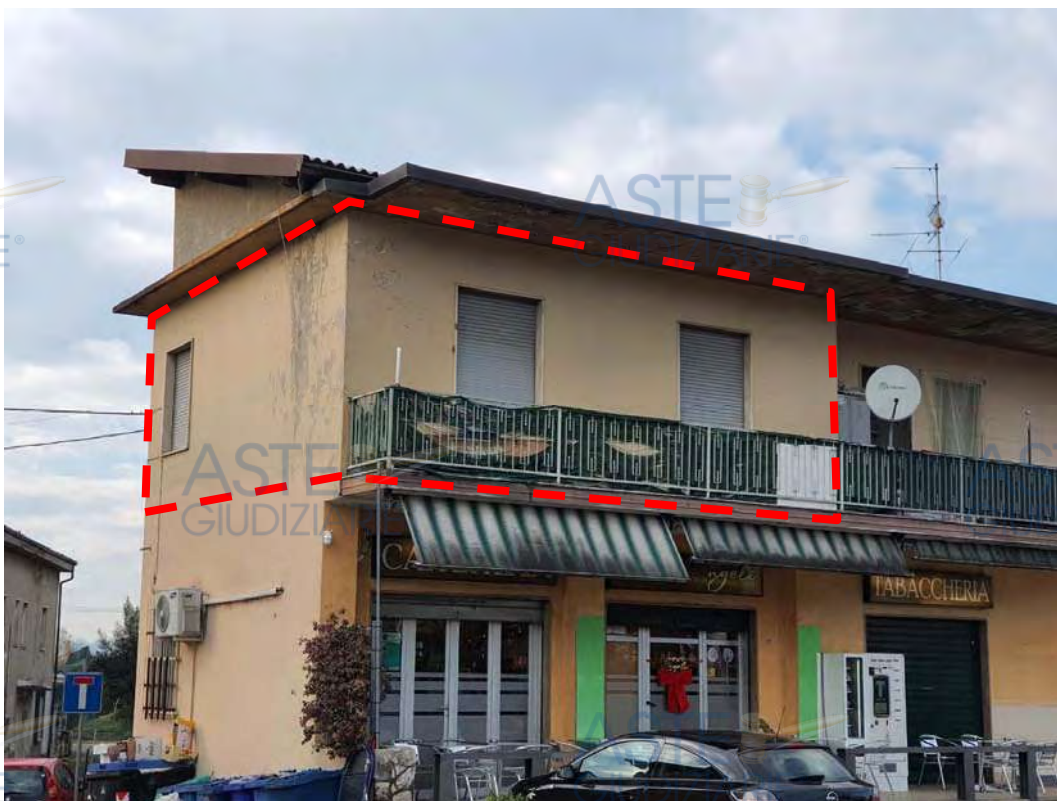
RILIEVO ESTERNO FABBRICATO – Foto 6.
