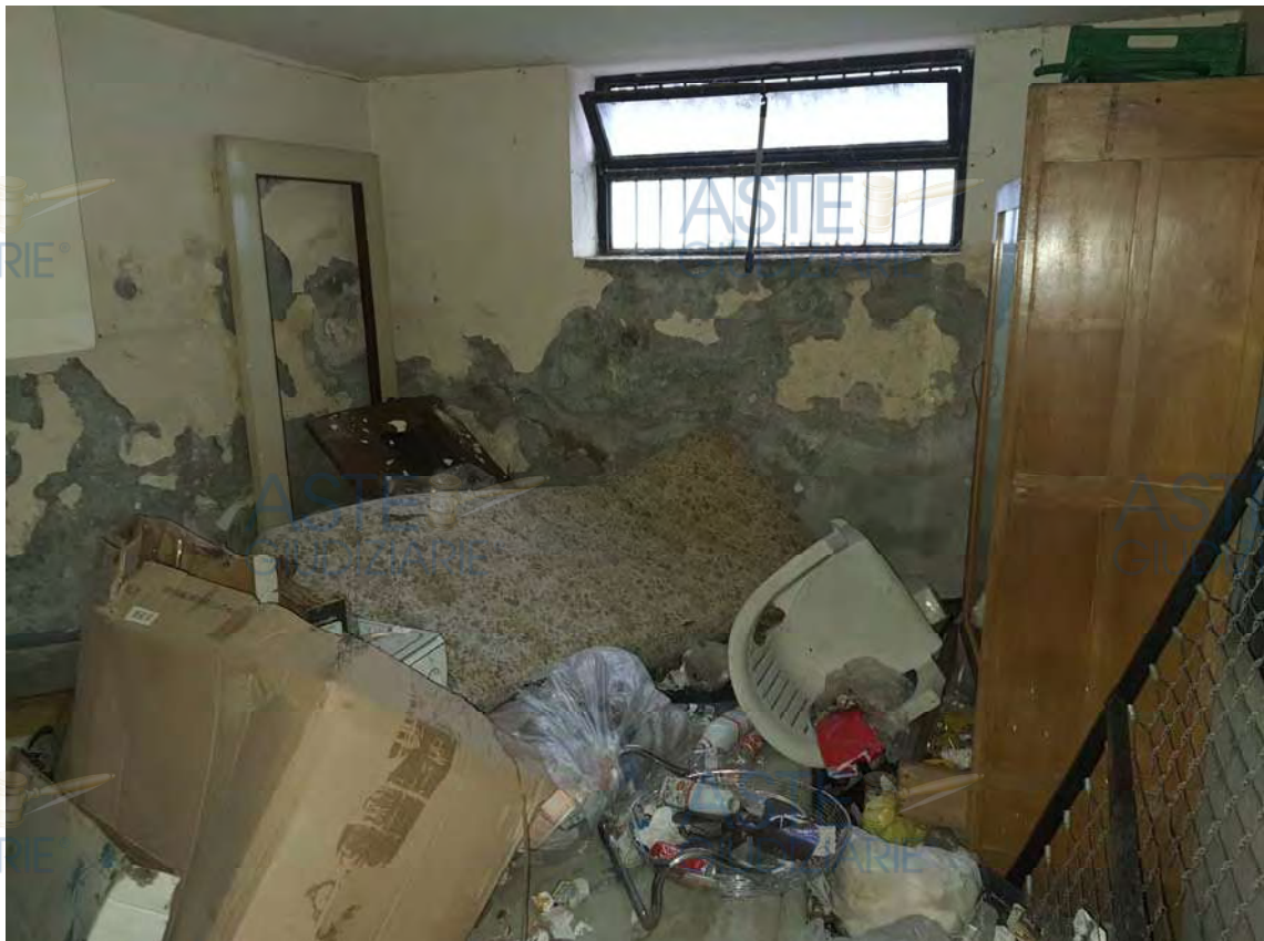
RILIEVO INTERNO POSTO (ex) AUTO COPERTO - P. INT. – Foto 63. Riprese dell' ex Posto Auto Coperto (Sub. 708), ora trasformato in ripostiglio.
