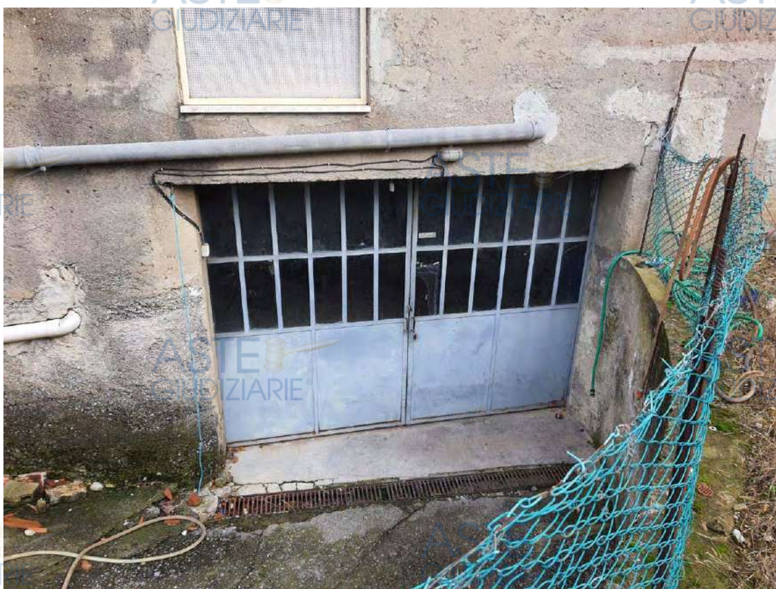
RILIEVO ESTERNO FABBRICATO – Foto 9 e 10.
