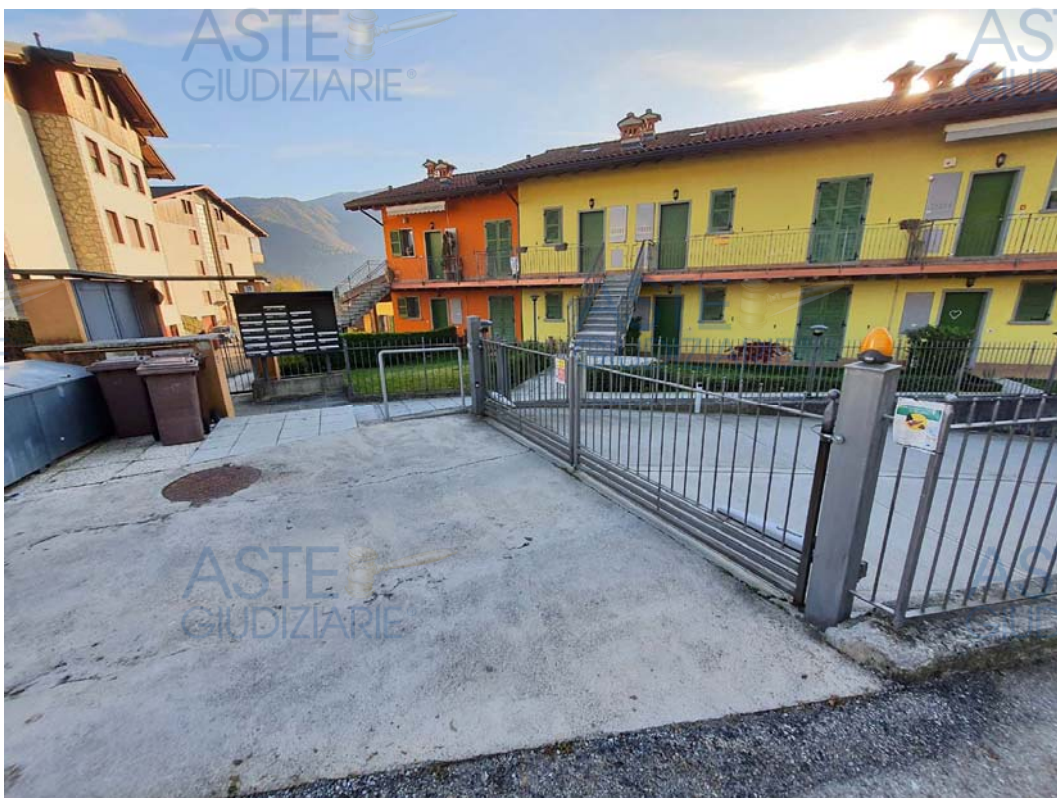
RILIEVO ESTERNO FABBRICATO – Foto 19 e 20.
