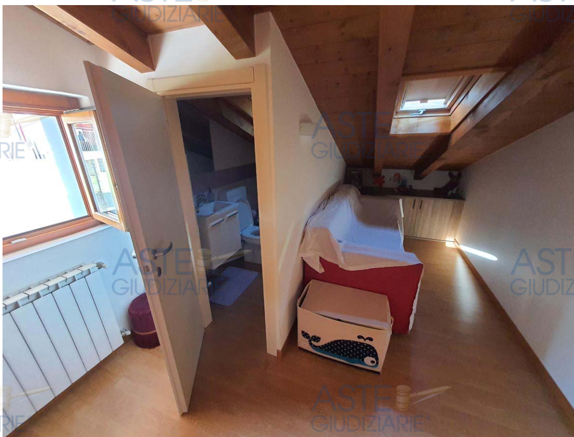
RILIEVO INTERNO ABITAZIONE - P. SOTTOTETTO – Foto 43 e 44. Riprese del locale destinato a zona notte a questo livello e del locale bagno.
