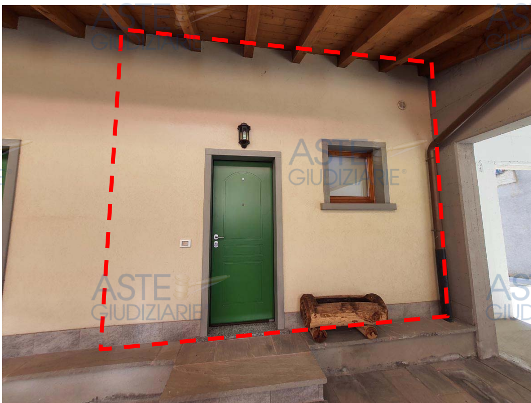
RILIEVO ESTERNO FABBRICATO – Foto 3 e 4.
