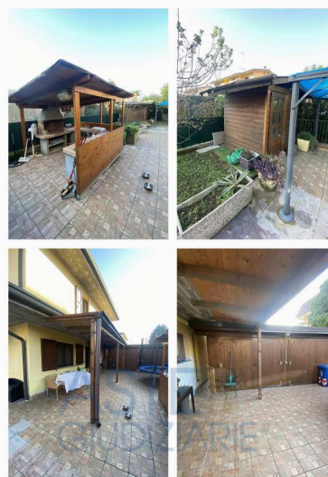
Manufatti esterni abusivi
