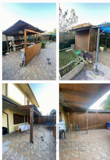
Manufatti esterni abusivi
