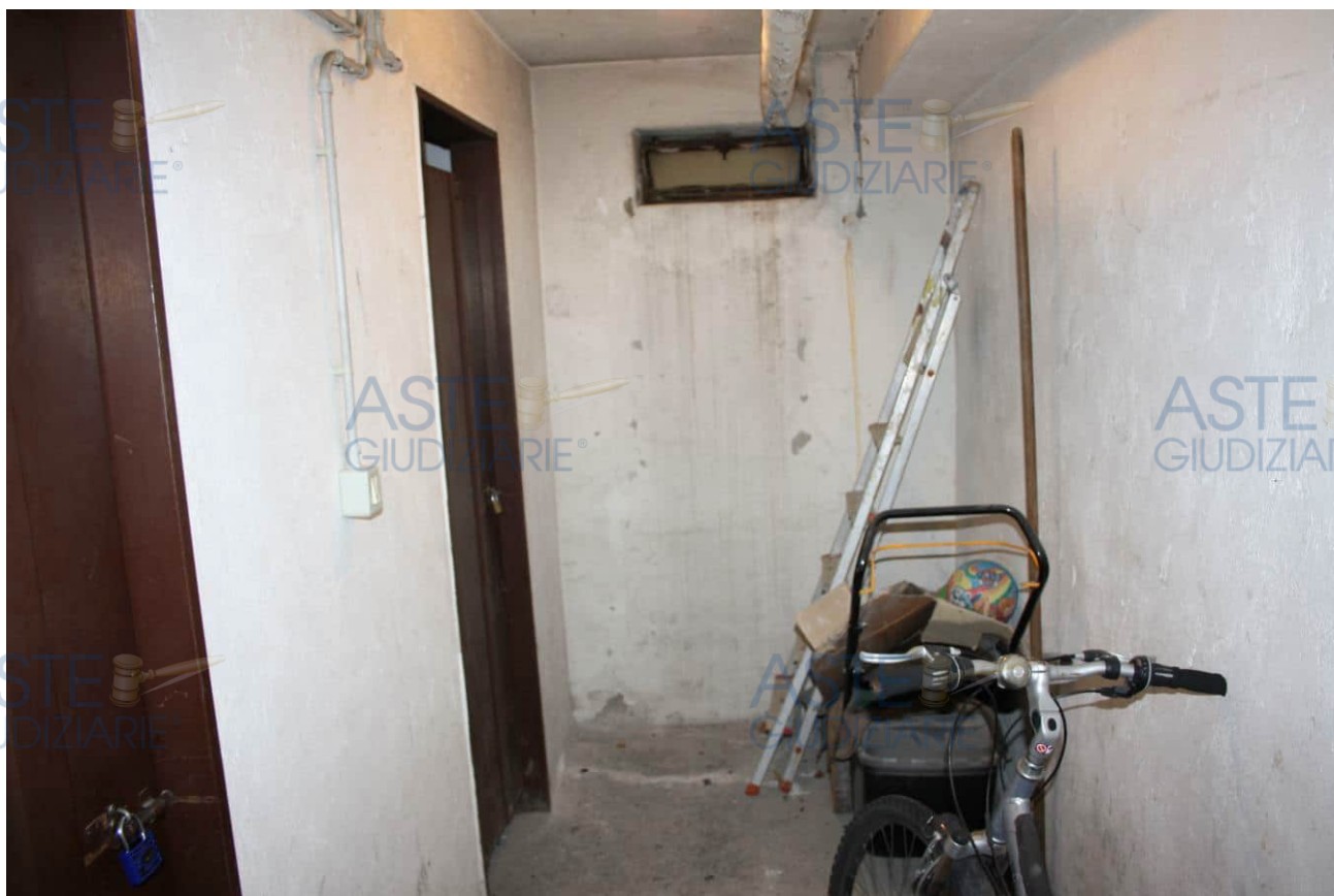
Disimpegno cantine al piano primo sottostrada.
