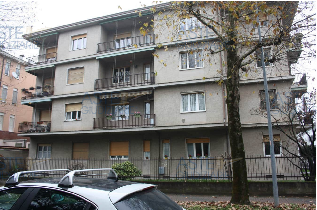
Prospetto ovest su Via Tasso.
