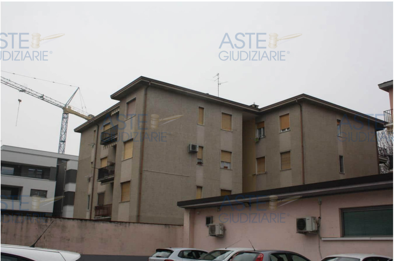
Prospetti nord ed est da cortile di altra ditta.
