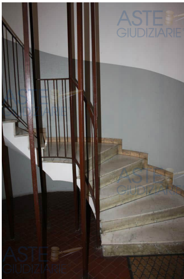
Scala di accesso al piano primo sottostrada.
