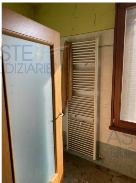
Porta del bagno al 1° piano
