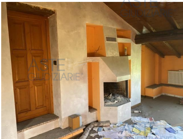
Porta chiusa e camino nel sottotetto
