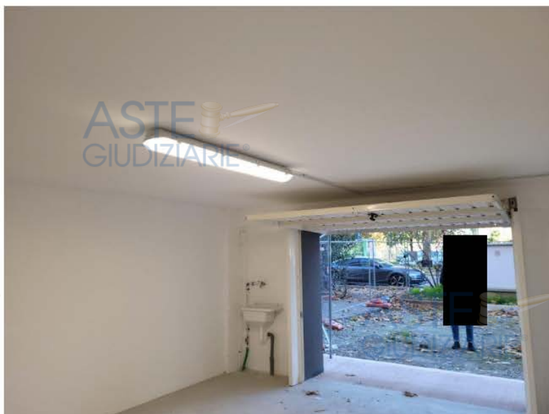
Autorimessa con impianto elettrico ed idrico
