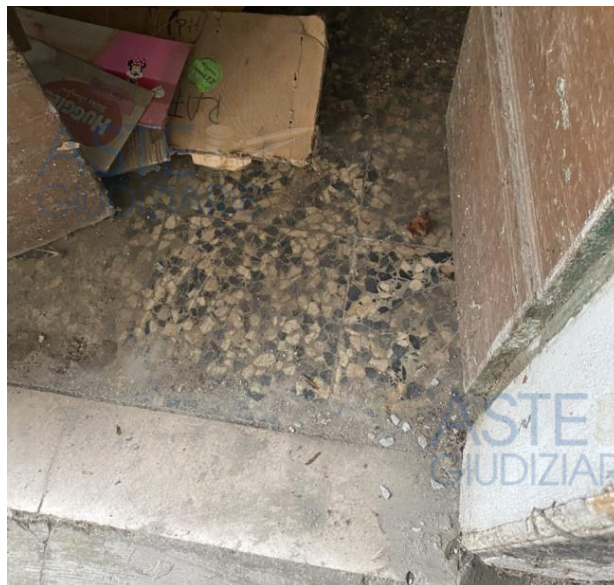
Pavimento del ripostiglio
