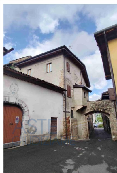
vista dal vicolo Castello (2° piano)
