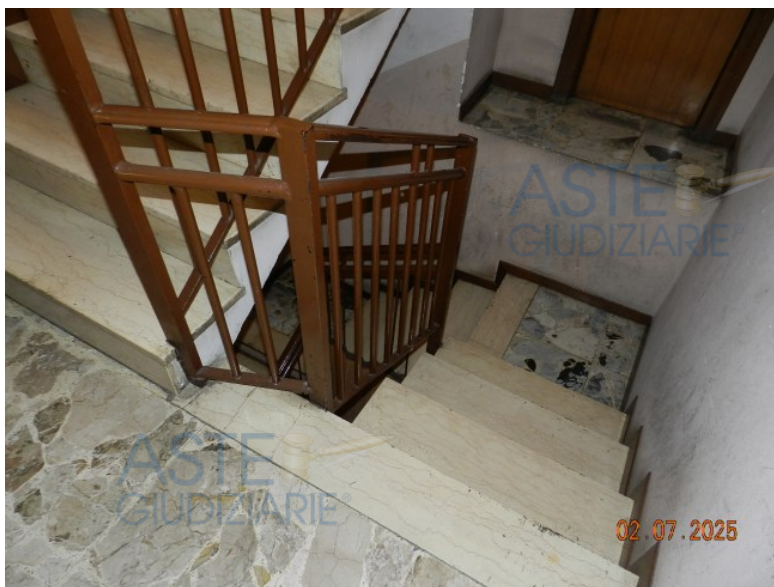
LA SCALA DI ACCESSO AL PIANO INTERRATO
