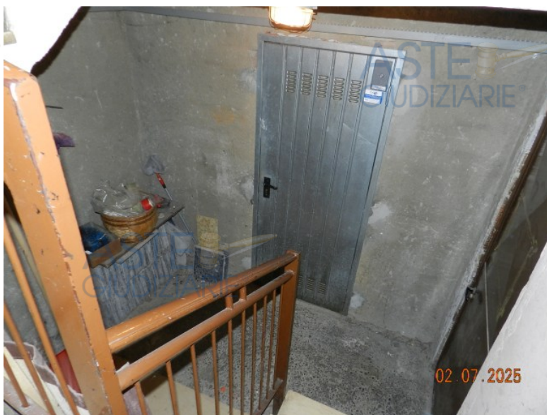
LA PORTA CHE CONDUCE AL DISIMPEGNO CANTINE
