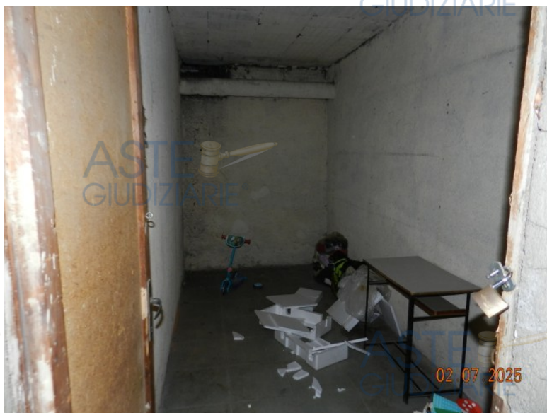
INTERNO DELLA CANTINA ESECUTATA
