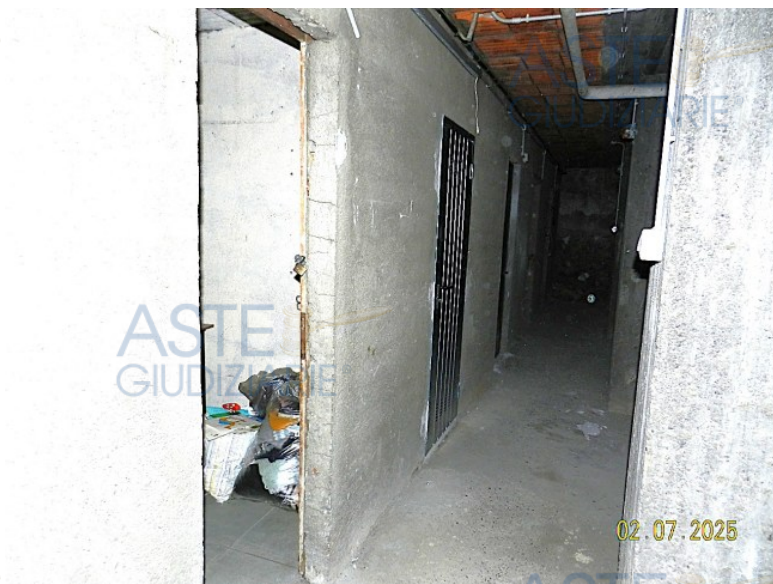
IL DISIMPEGNO CANTINE E SULLA SINISTRA LA CANTINA IN ESECUZIONE
