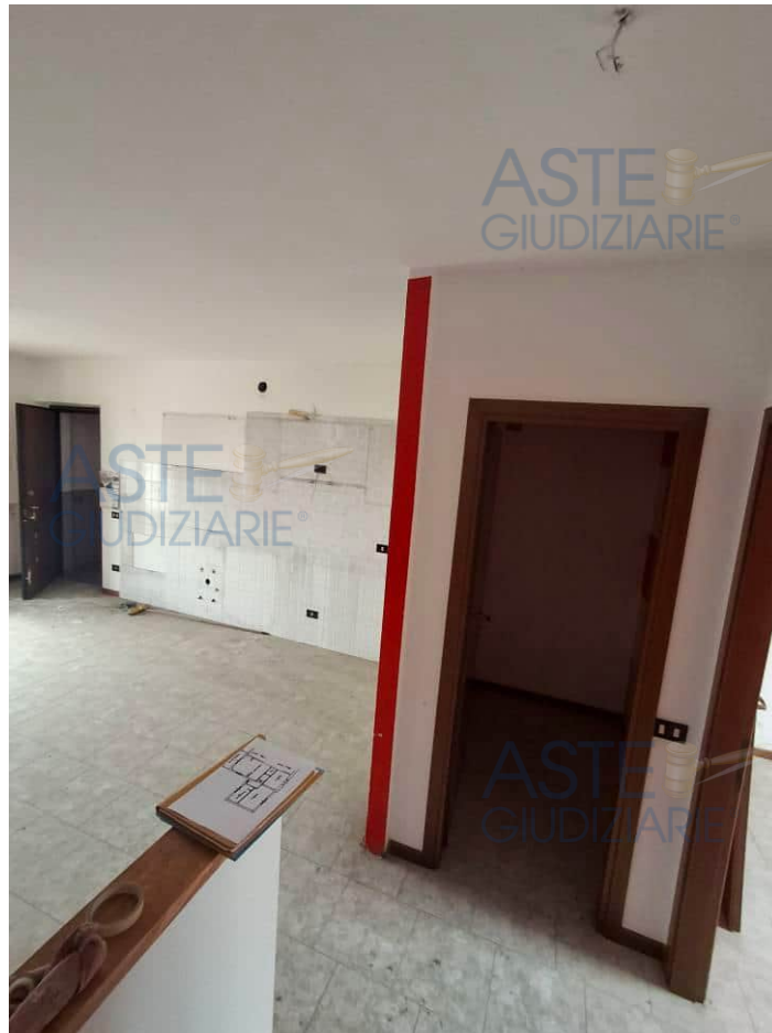
9) Veduta soggiorno e ripostiglio
