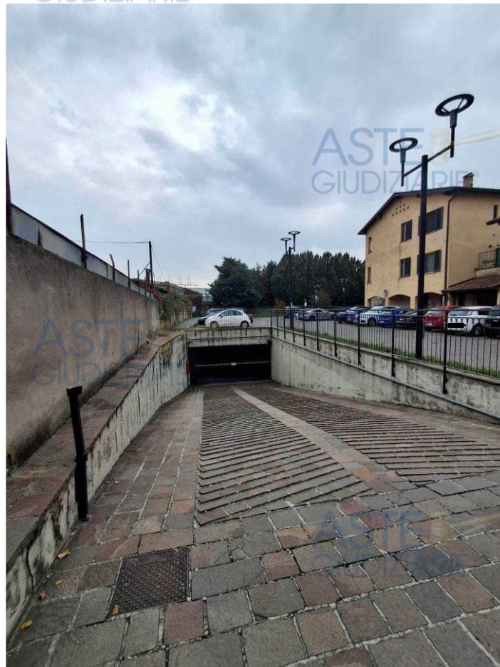
16) Rampa di accesso alle autorimesse
