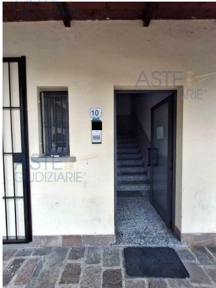
6) Veduta ingresso vano scale condominiale
