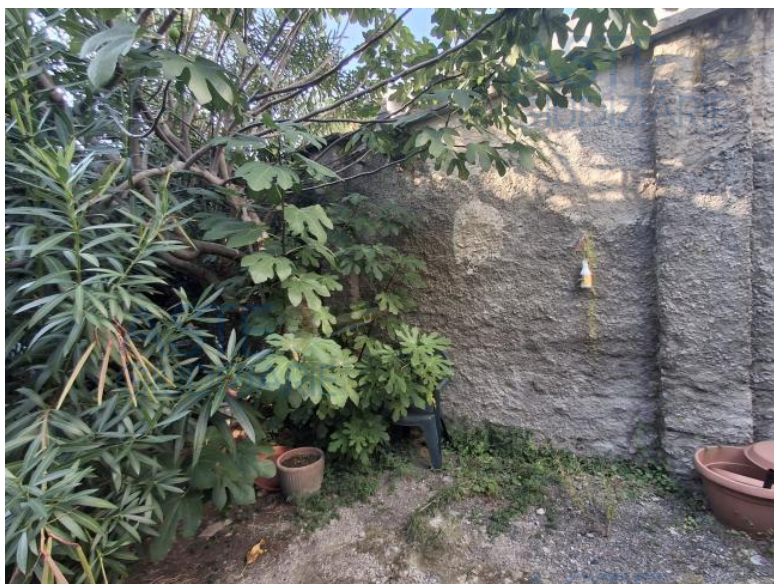
Veduta area scoperta
