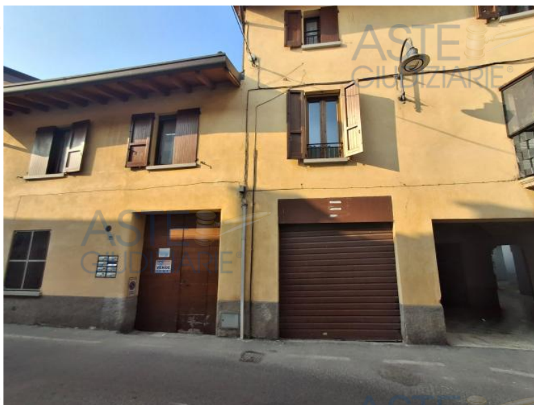
Veduta accesso carrale
