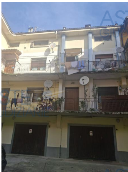
Prospetto esterno con a sinistra finestrino u.i.
