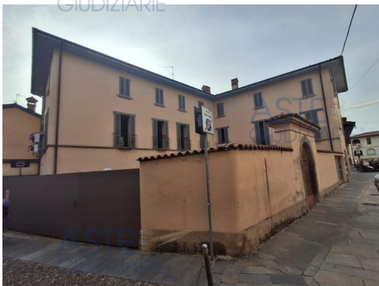
Veduta esterna fabbricato
