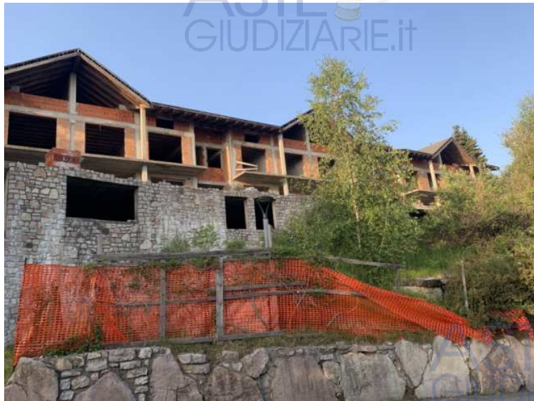
Area di cantiere-edificio sud
