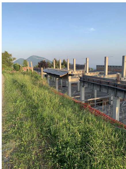
Area di cantiere-Edificio nord
