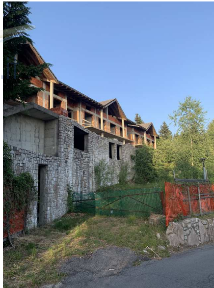
Area di cantiere-edificio sud e ingresso
