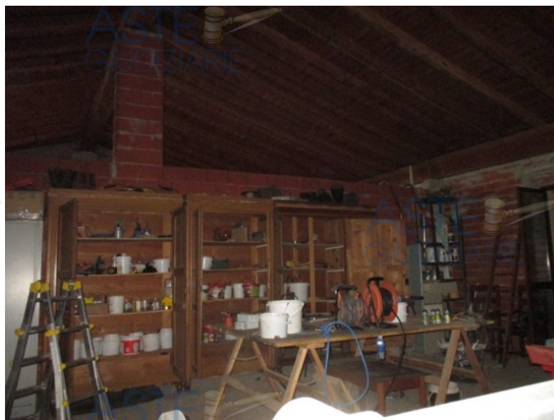
porzione al rustico primo piano
