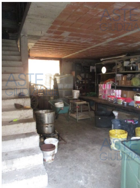
porzione al rustico piano terra
