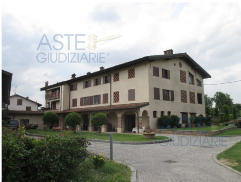
vista dal cortile
