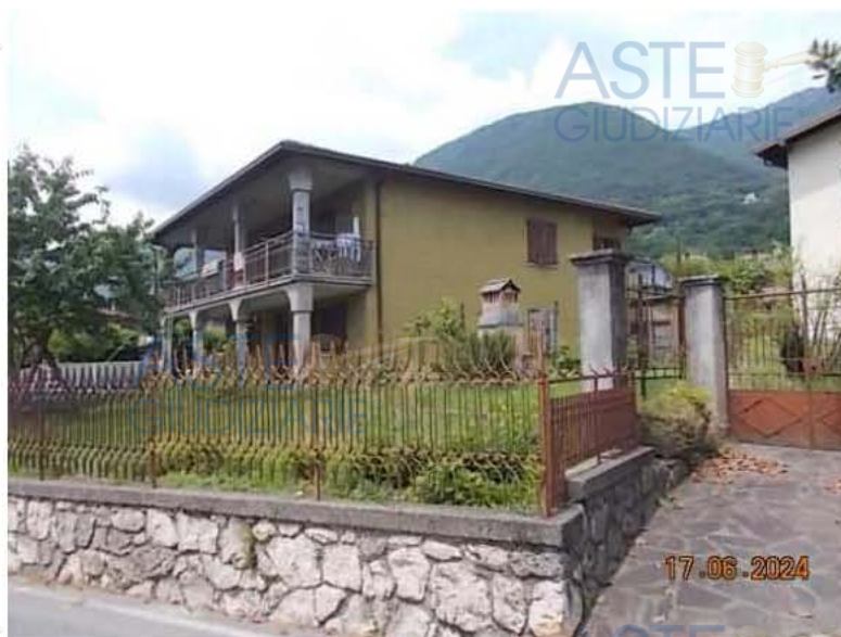
Fronte sud Piano primo
