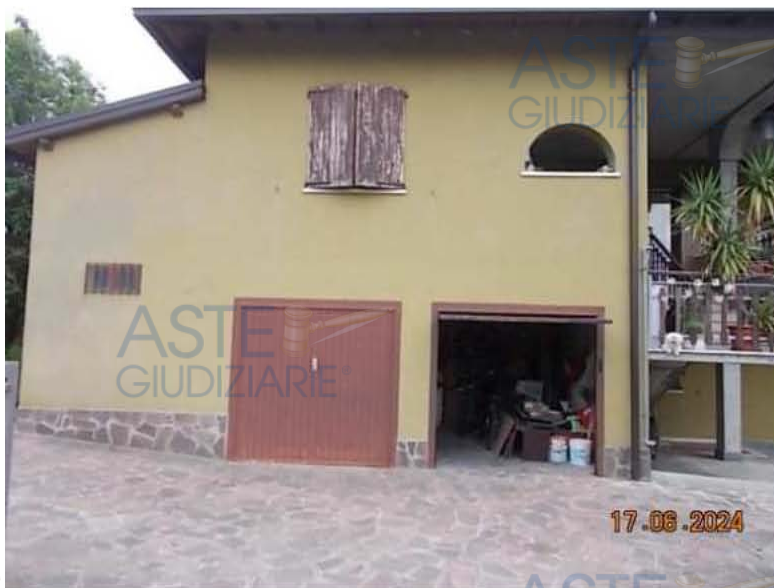
Autorimessa destra spazio di manovra comune
