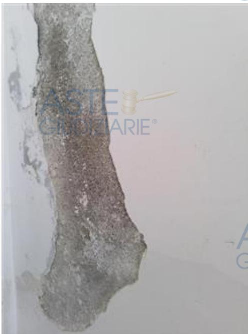
*intonaco interno danneggiato per infiltrazioni ed umidità di risalita*
