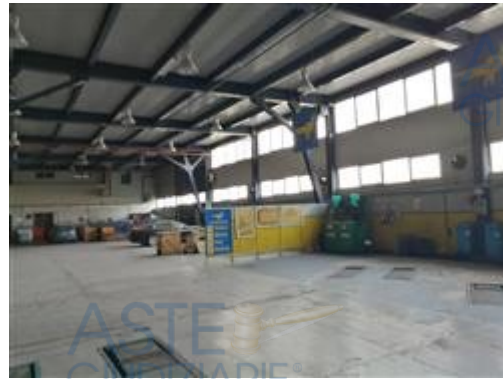
Officina meccanica al piano terra
