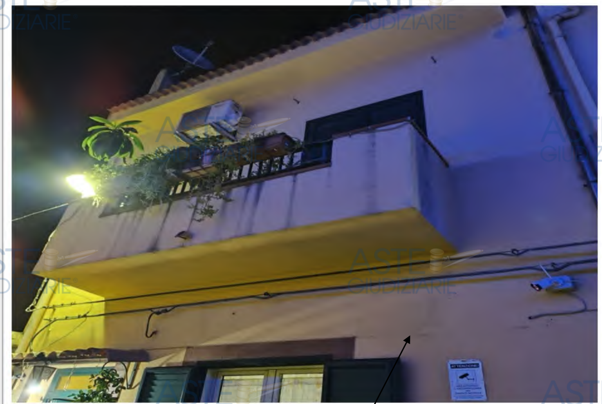
Prospetto principale sulla via Idria nc. 50
