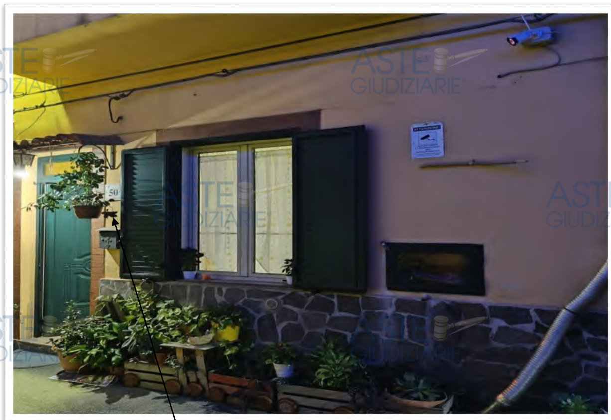
Prospetto principale sulla via Idria nc. 50
