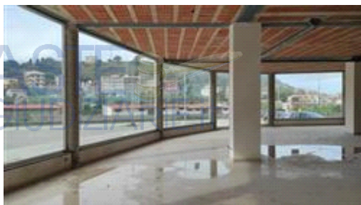
lato NORD/OVEST - area commerciale
