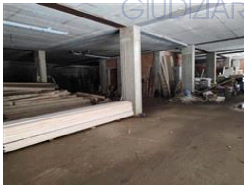
Locale cantinato - ingresso interno
