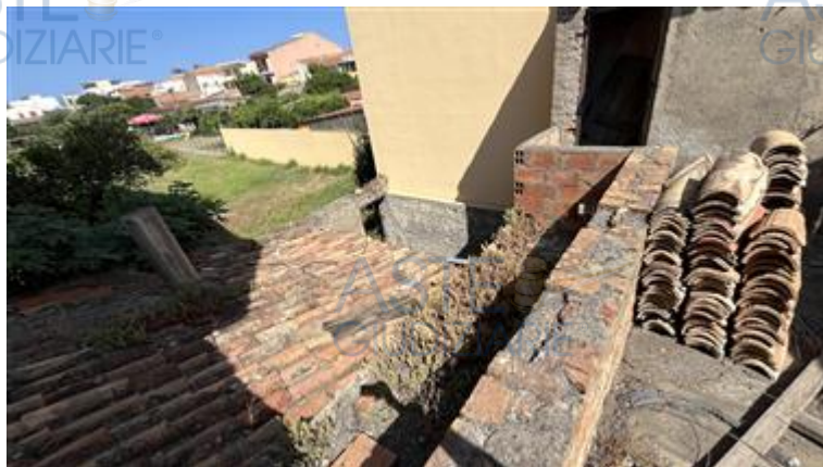
Vista dal terrazzo del piano primo del fabbricato
