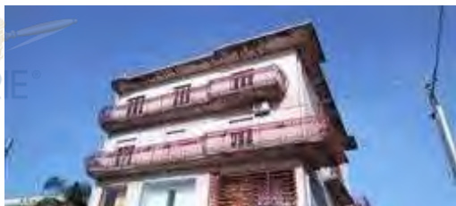
Vista esterna fronte strada principale
