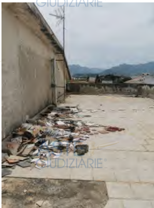
Piano quarto Lastrico solare
