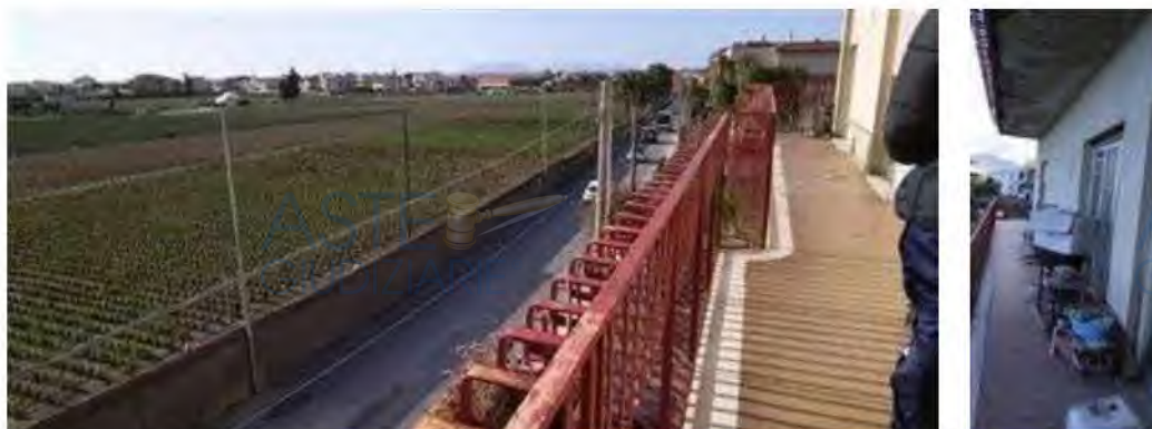
Vista esterna - prospetto principale
