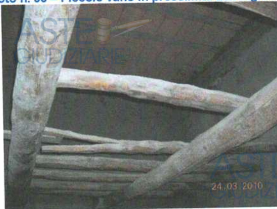
Foto n. 38 - Orditura del vecchio solaio in legno
