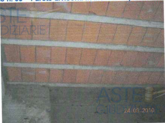
Foto n. 37 - Solaio in laterocemento
