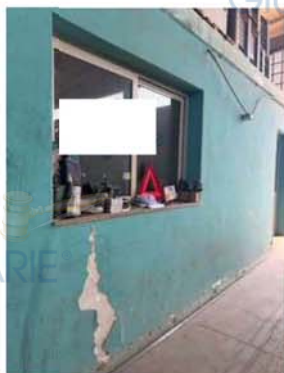
blocco ufficio spogliatoio e wc
