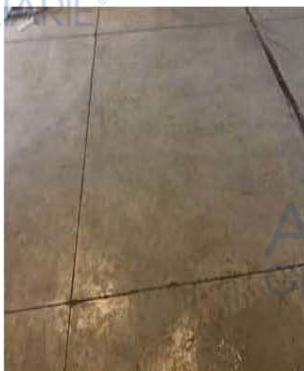
Dettaglio pavimento in cemento
